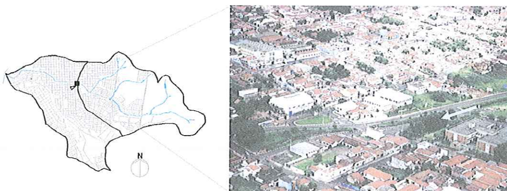
Figura 7.7b: Região final da área de estudo. Sentido montante-jusante. Foto: PMCS/SMH DU (2004)
