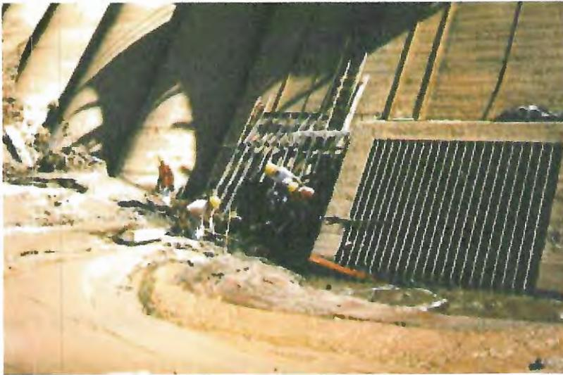
**Figura 5: Vista das grades da tomada d'água e da comporta de fundo do Reservatório de Cariobinha. Início da desobstrução (MAIA, 2006).**
