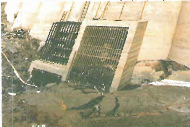
**Figura 6: Vista das grades da tomada d'água e da comporta de fundo do Reservatório de Cariobinha, durante os trabalhos de desobstrução. (MAIA, 2006).**
