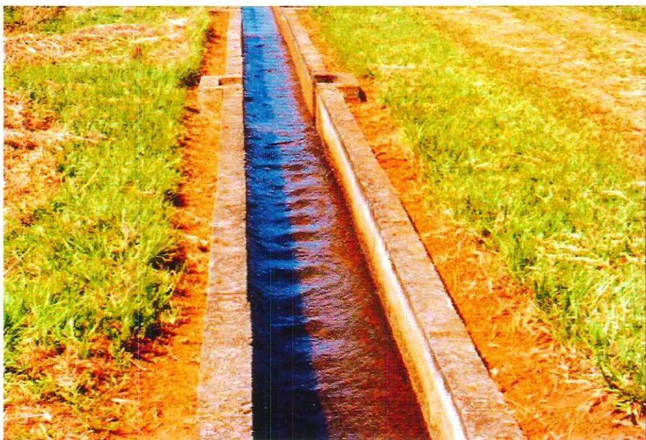
Figura 1. Canaleta de abastecimento dos tanques de piscicultura.
