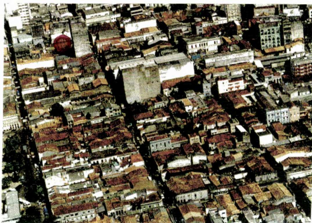
FIGURA 10 - Vista aérea do Bairro do Reduto.
