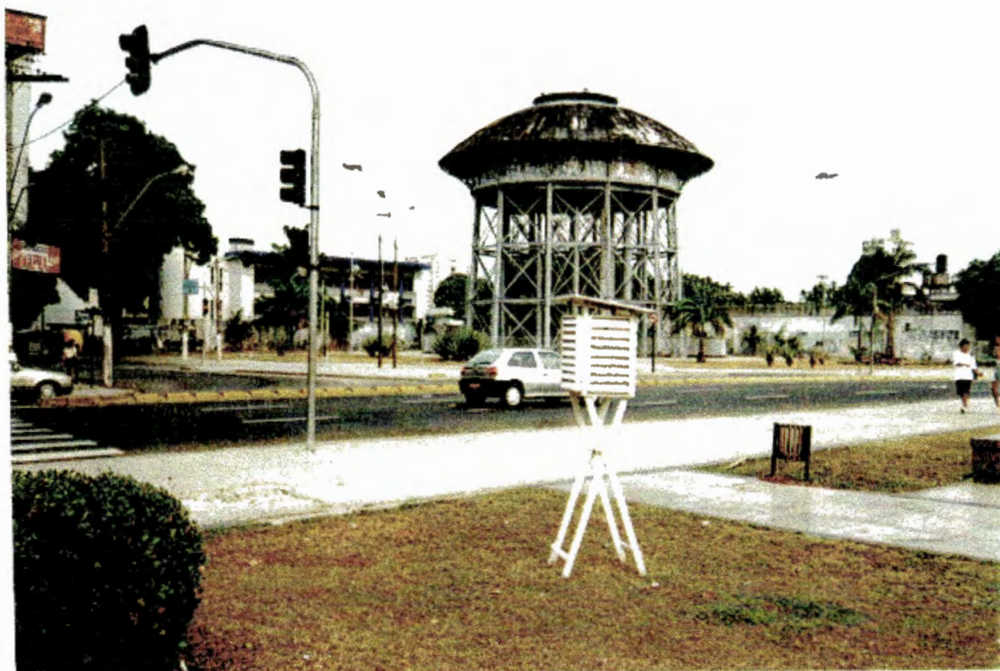
FIGURA 29 - Local de observação meteorológica na Avenida Almirante Barroso com Avenida José Bonifácio, no bairro de São Brás (Local 10).
