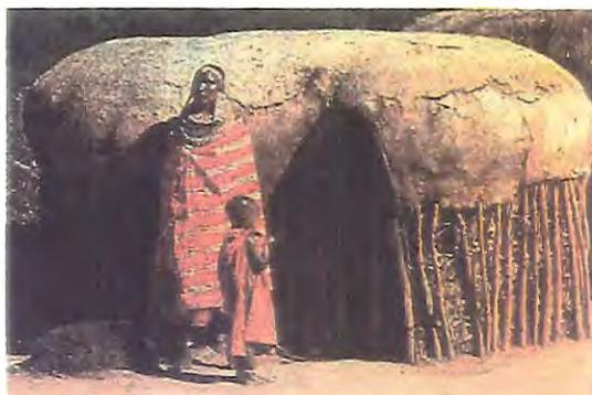
**FIGURA 09 - Cabana Maasai - Quênia.** Abrigo construído de terra e fibras naturais, de alta inércia térmica, com poucas aberturas, para garantir a proteção contra os rigores do clima quente seco (temperaturas altas durante o dia e baixas durante a noite, além da presença de ventos quentes e carregados de poeira).
