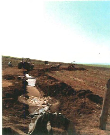
Figura 24: Canal de vinhaça sem impermeabilização
