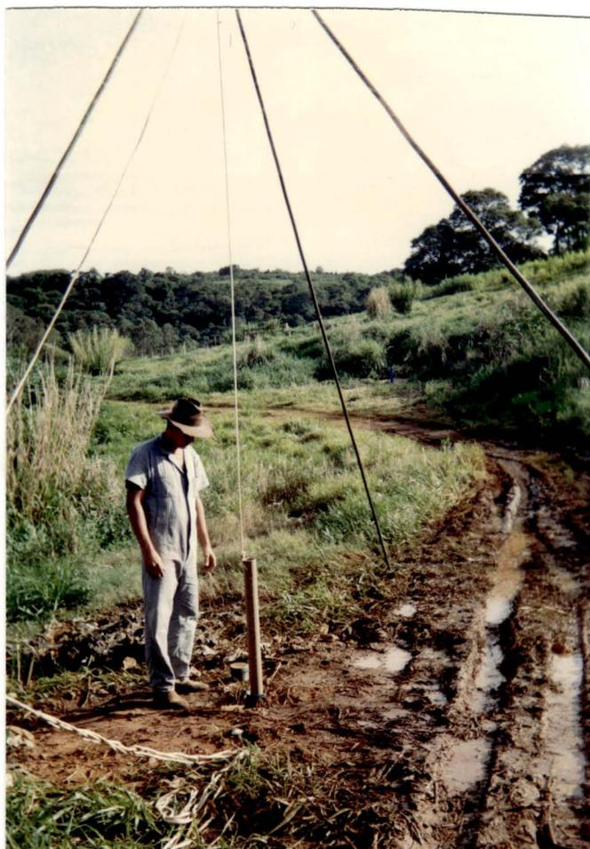
Figura 19: Operação de desenvolvimento dos poços de monitoramento e amostragem
