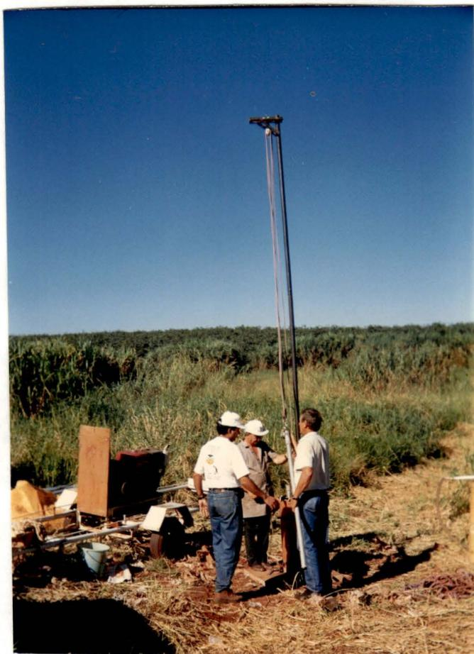
Figura 22: Tubos elevatórios da bomba.
