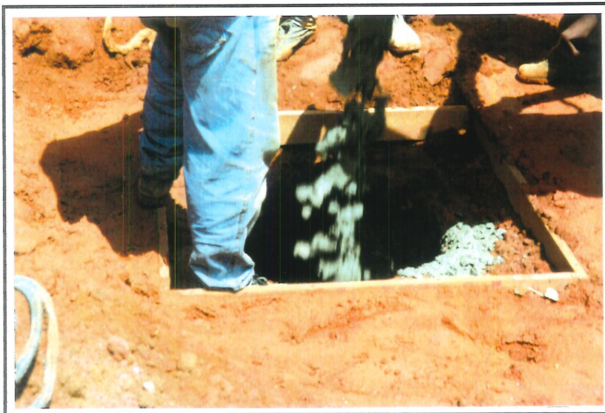
Concretagem dos tubulões.
