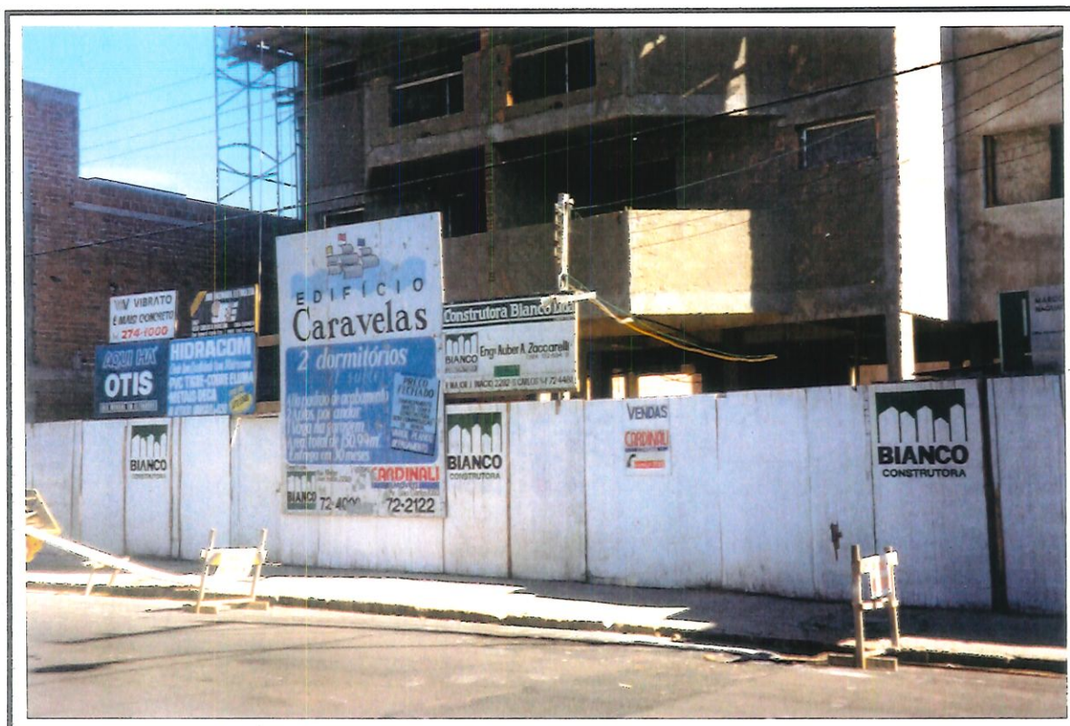
Fachada do Edifício Caravelas: internamente em fase de reboco.
