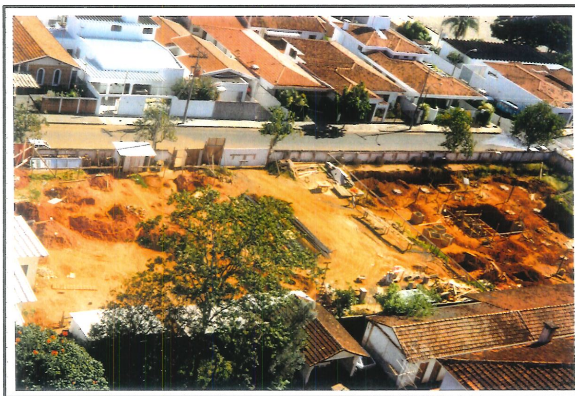
Vista aérea: pode-se avistar o rebaixamento do terreno à direita e o acúmulo de terra à esquerda.
