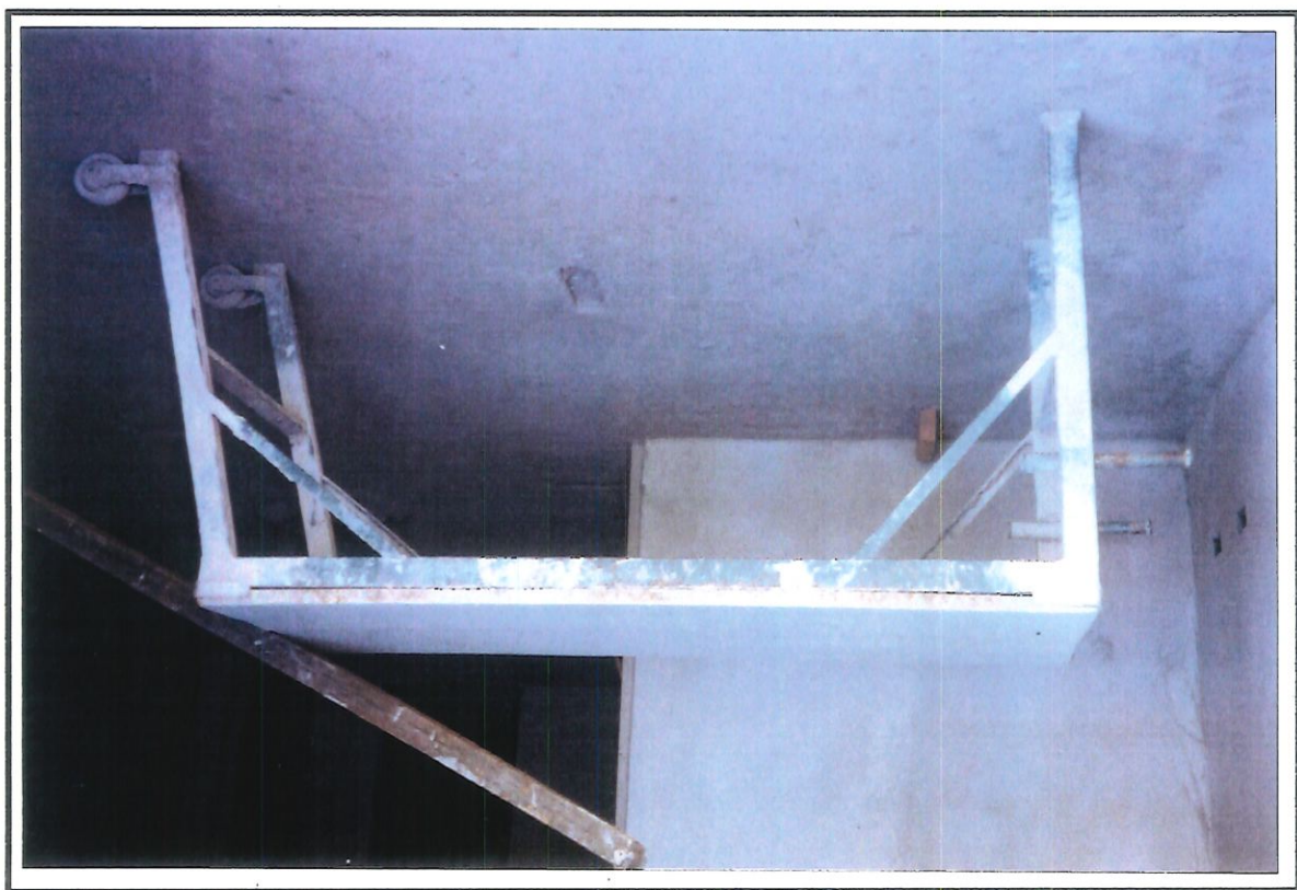
Masseira metálica para revestimento: inovação utilizada no Edifício Caravelas.
