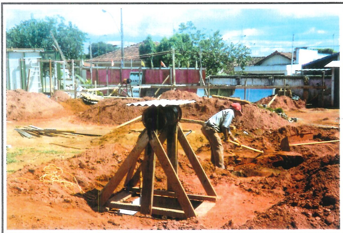
Abertura dos tubulões no terreno não rebaixado.
