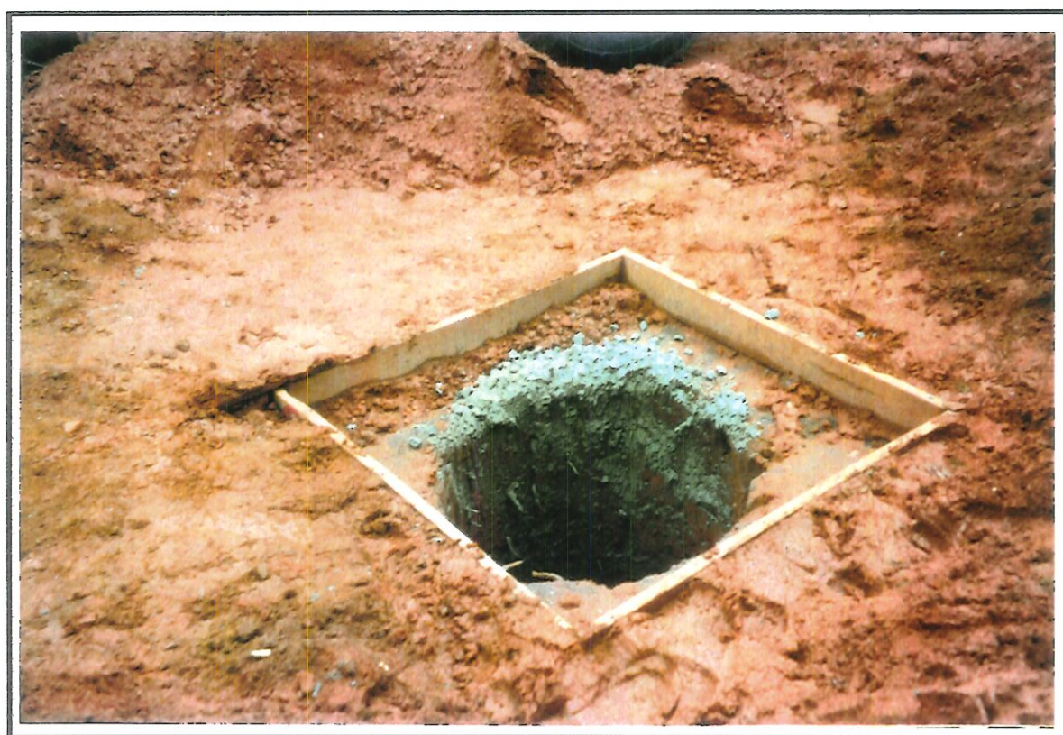
Finalização da concretagem: desperdício.
