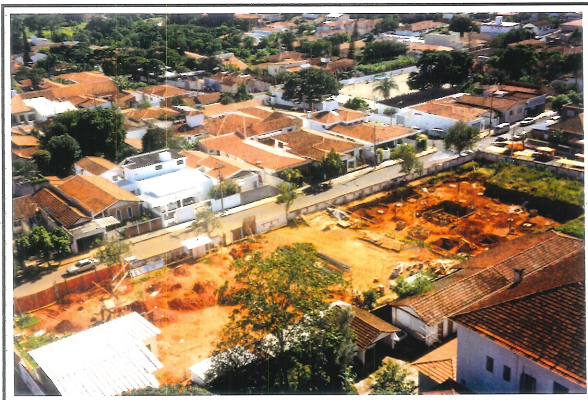
Vista aérea do terreno: apartamento modelo à esquerda.
