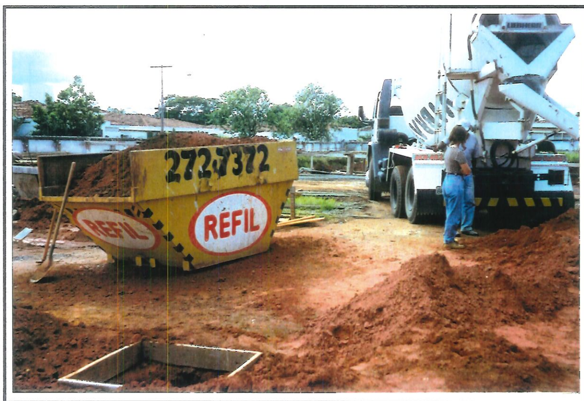
Dificuldade de movimentação do caminhão para concretagem dos tubulões.
