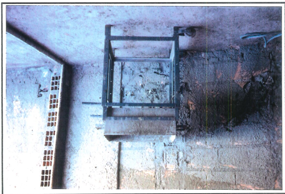
Masseira metálica para revestimento: inovação utilizada no Edifício Caravelas.
