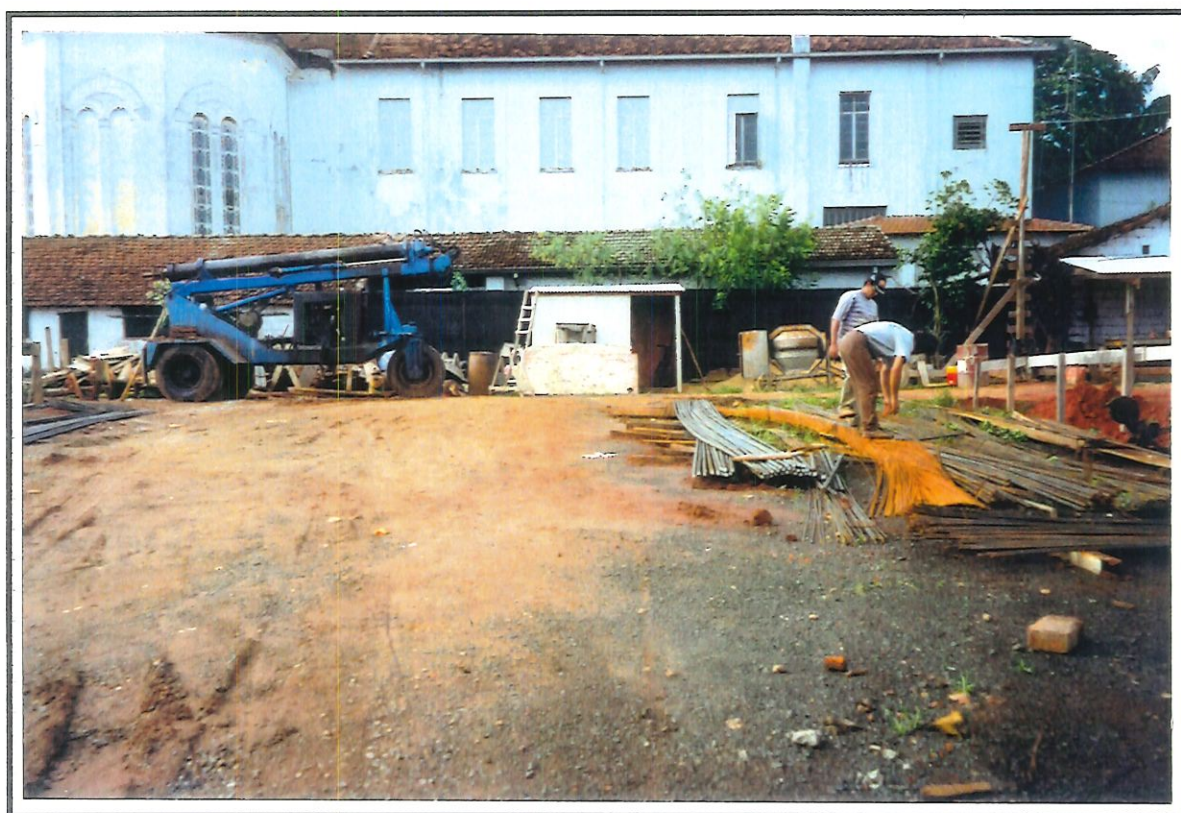
Movimentação de materiais no canteiro.
