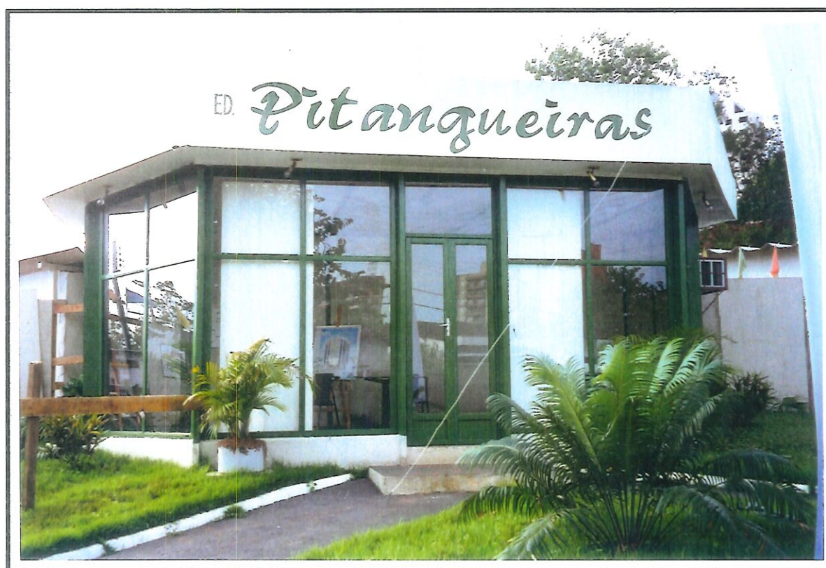
Fachada dos Edifícios Pitangueiras e Tabatinga: em fase de fundações. Trata-se da entrada para apto modelo.
