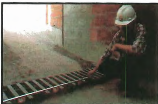
Figura 3.7.M – Régua com nível grande
