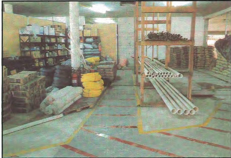
Figura 5.7 – Almoxarifado de canteiro de obras.
