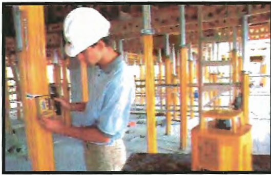
Figura 3.7.H – Nível a laser
