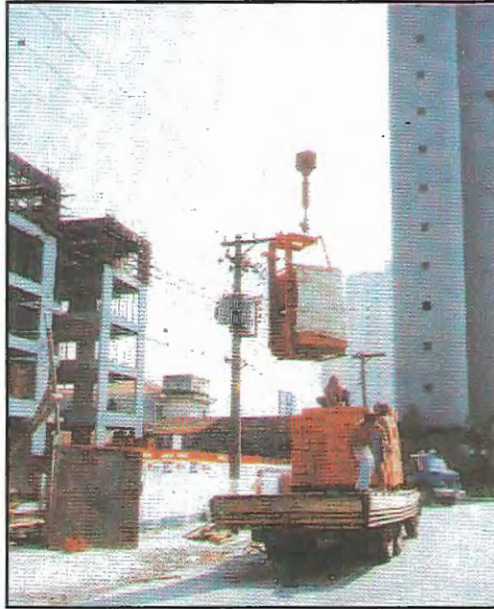
Figura 5.9 A – Transporte Vertical de Materiais.
