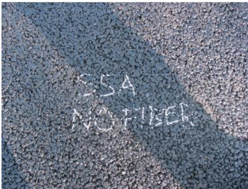
Figura 2.5 – Revestimento compactado em campo de Stone Skeleton Asphalt (SSA) sem fibras (Hurley & Prowell, 2008)
