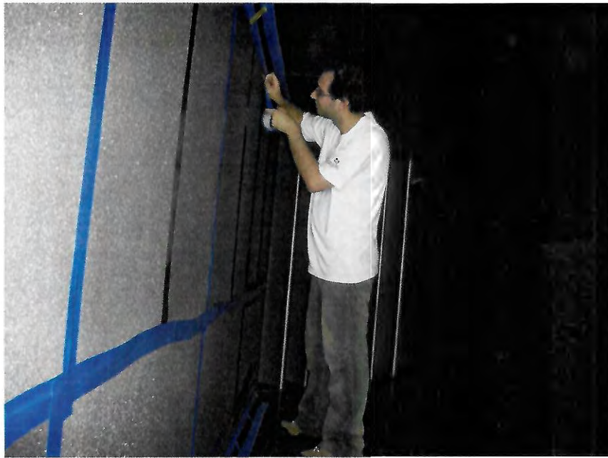
Figura 4.8: Foto da divisória instalada no túnel após a conclusão do trabalho.
