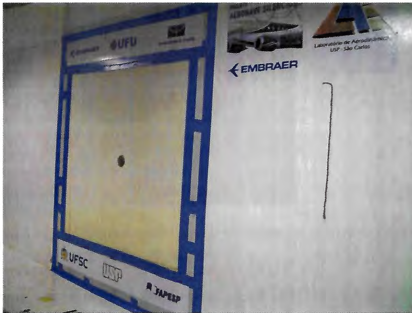
Figura 6.3: Vista frontal da placa de microfones instalada no túnel de vento LAE-1.
