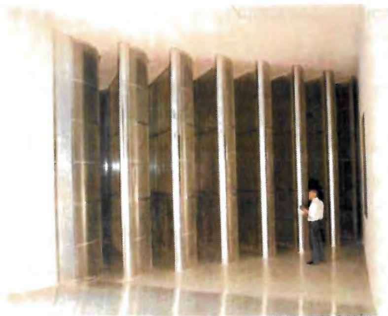
Figura 2.5: Vista das guias de curva acusticamente tratadas do túnel aeroacústico da Audi. Figura retirada de (BRANDSTATT; FUCHS; ROLLER, 2002).
