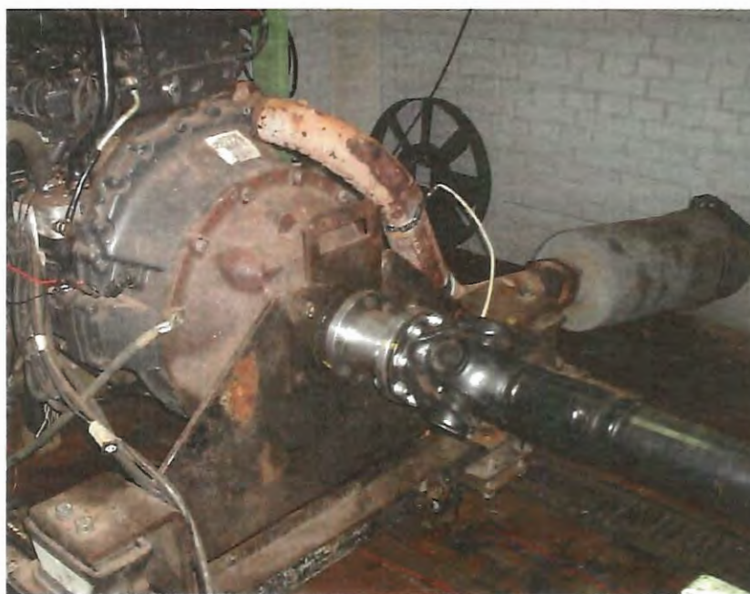
Figura 74. Posicionamento do escapamento do motor para a parte externa do prédio
