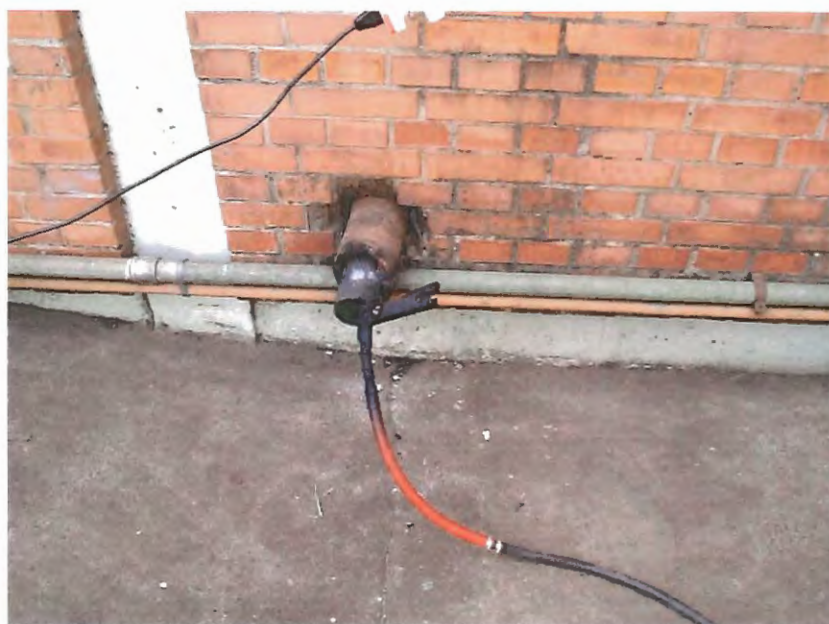
Figura 75. Local de medição da emissão de gases do motor na parte externa do prédio
