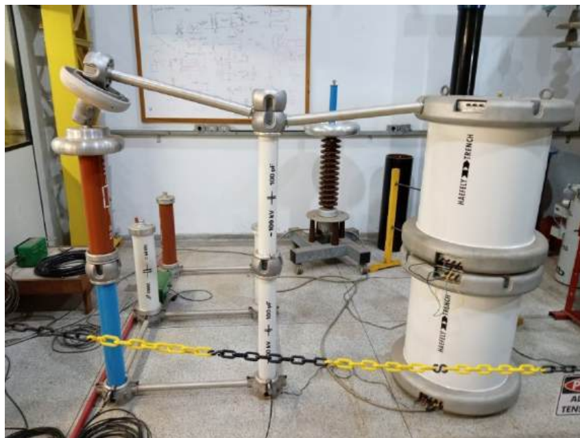
Figura 37 – Circuito final do ensaio CA com dois transformadores conectados em cascata
