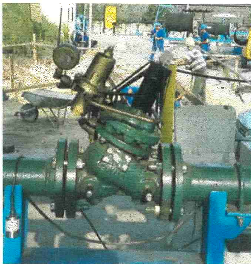
Figura 5.24 – Sensor acoplado a VCA
