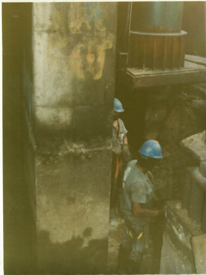
EXCAVAÇÃO E PREPARAÇÃO DE FORMAS
