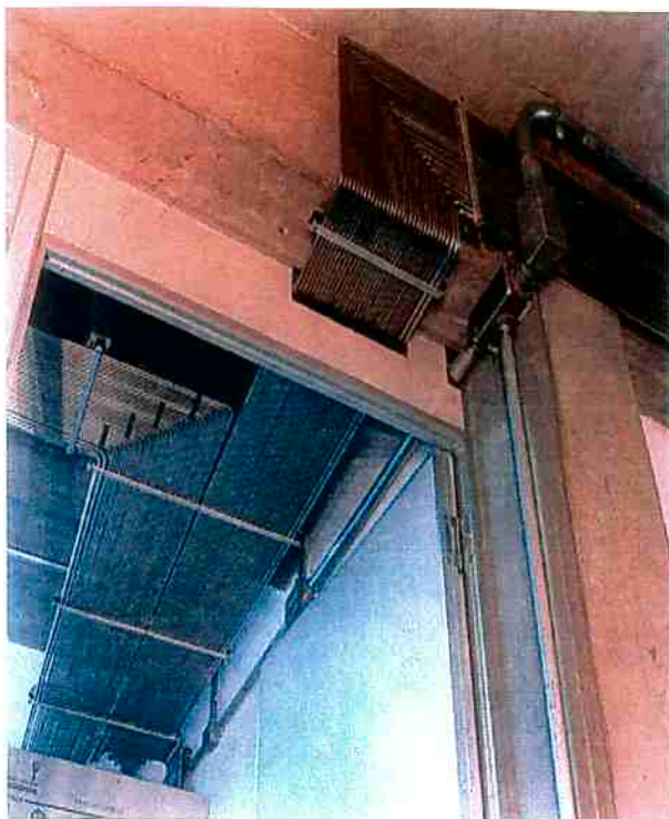
Fig. 4.5 – Detalhe das linhas de gases para bancada de análise.
