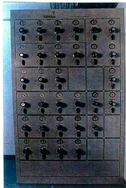
Fig. 4.6 – Painel de ajuste de pressão de gases.
