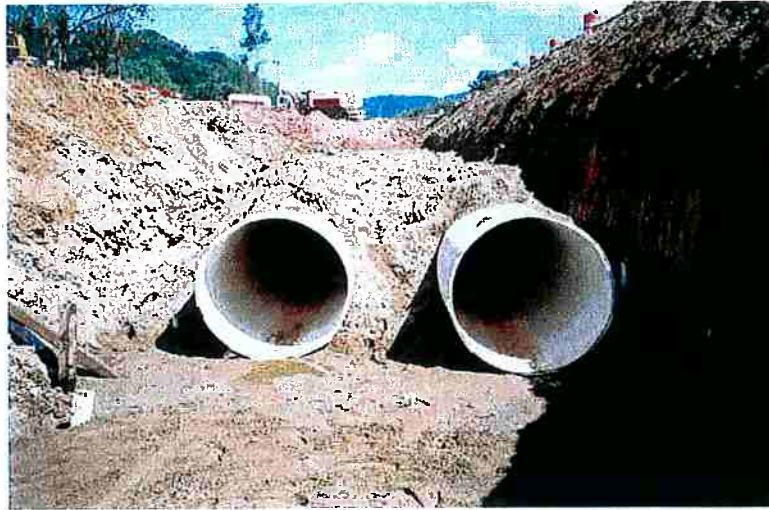
Figura 1.2 Tubo estruturado montado em obra de drenagem de águas pluviais
