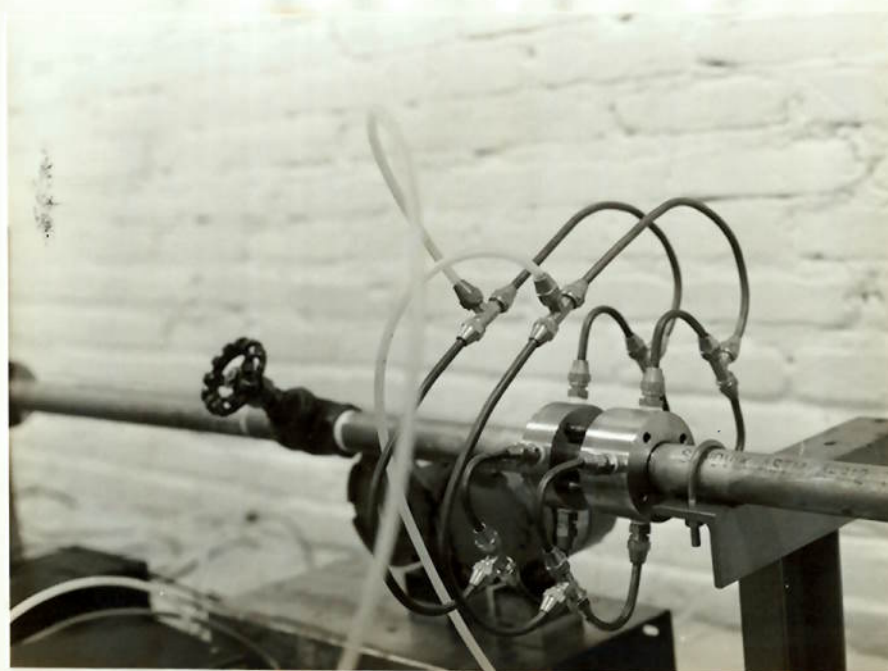
FIGURA 25 - Tomadas de pressão tipo triplo T, à montante e à jusante do Venturi (detalhe da tubulação de ensaio)
