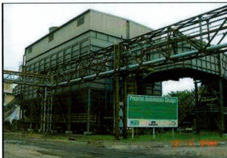
Figura 66 – Sistema de despoejamento secundário da aciaria #2
