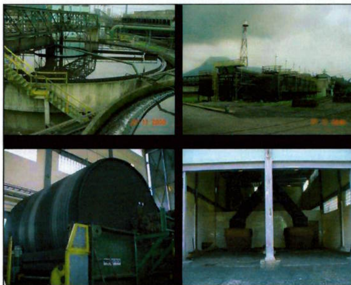
Figura 72 – Sistema de tratamento e recirculação de águas das laminações (LSTRA) (a) Tanques de decantação, (b) sistemas de filtros, (c) filtro a vácuo, (d) caçambas de recolhimento da lama.
