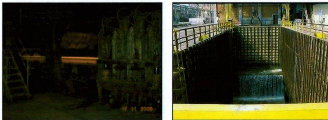
Figura 65 – Máquina de lingotamento contínuo MLC#2 (aciaria #2 / COSIPA) e poço de decantação de carepas das MLC (#1, #2 e #3)
