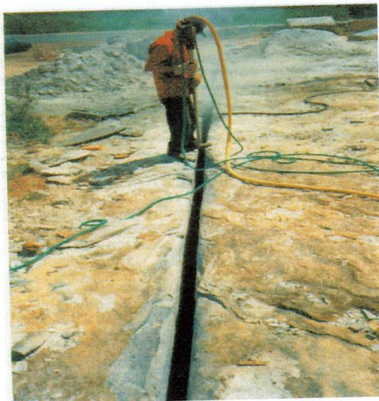
fig. 6 – Corte da rocha usando maçarico - *FLAME JET*.
