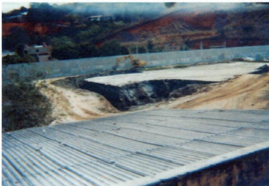
**fig.29 – Limpeza da barragem e transporte do rejeito para o bota fora**
