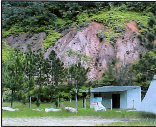
FOTO 8.10 Erosão em ravina acompanhada de escorregamento estruturado, km 353+250 LD.
