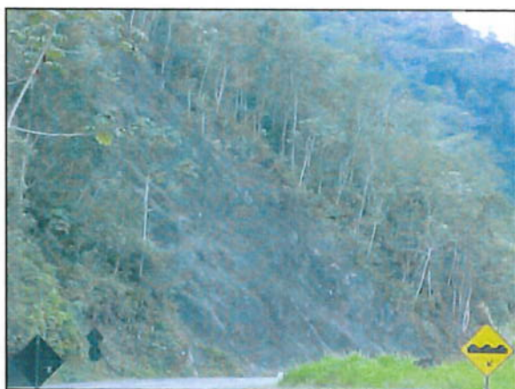
FOTO 8.19 Obra de contenção tipo concreto projetado, km 379+500 LD.
