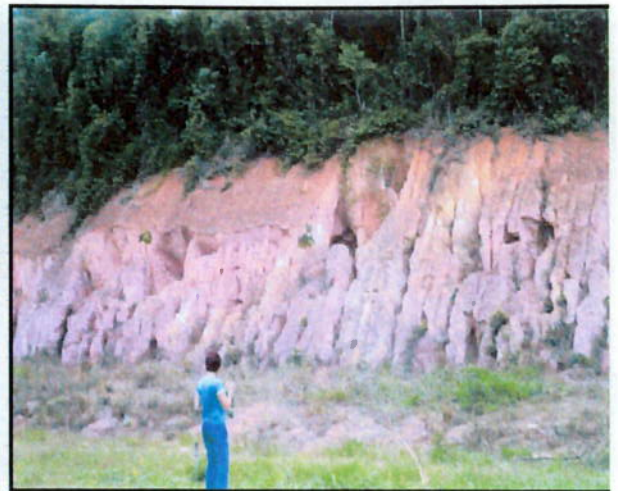
FOTO 8.11 Erosão em sulco e ravina, km 389+900 LE.
