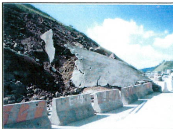
FOTO 1.2 Rodoanel Mário Covas. Observam-se materiais mobilizados de uma contenção pré-existente, parte da via interditada e o congestionamento da mesma.
