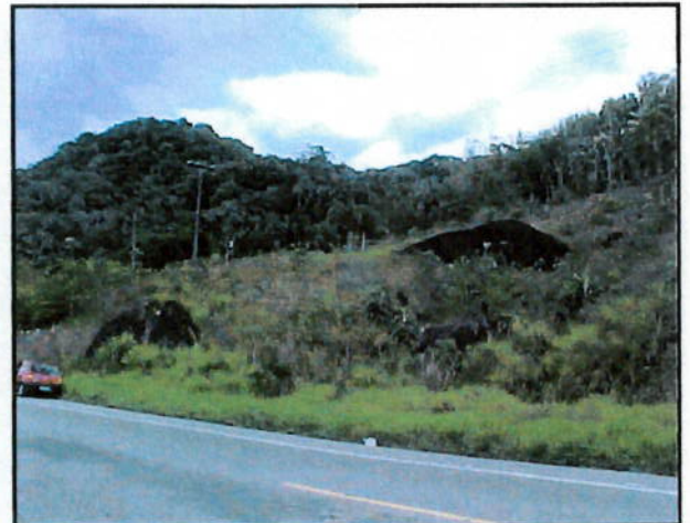
FOTO 8.4 Rolamento de matacão, e matacão imerso no solo de alteração de rocha, km 354+900 LD (Lado direito).
