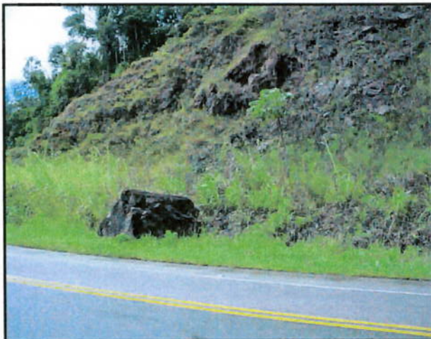
FOTO 8.3 Rolamento de matacão nas proximidades da pista, km 353+100 LE (Lado esquerdo).
