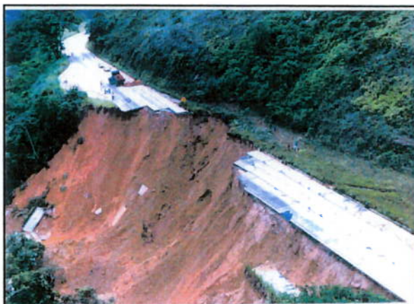
FOTO 1.3. Grande escorregamento ocorrido na BR-116-RJ, Rodovia Presidente Dutra. Nota-se que foram destruídas as pistas e que a rodovia ficou totalmente interditada. Fonte: LUCAREVSCHI (1993).
