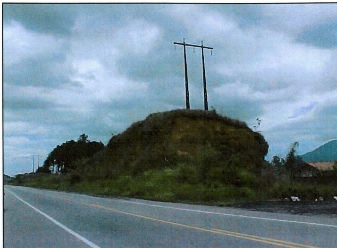
FOTO 8.18 Exemplo de passivo ambiental localizado na faixa de domínio e decorrente da ação de terceiros para retirada de material de empréstimo, km 354+800 LE.
