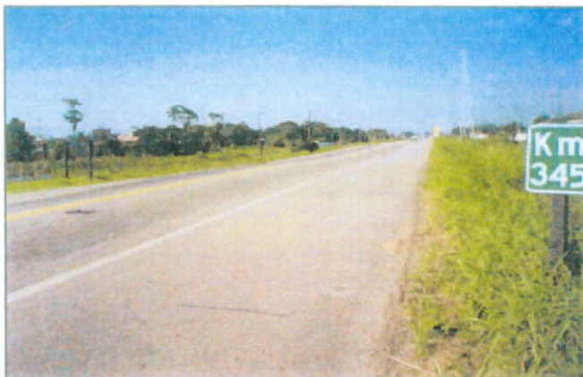
FOTO 7.2 Início do trecho onde a rodovia atravessa região com declividade quase nula (LENC, 2000).
