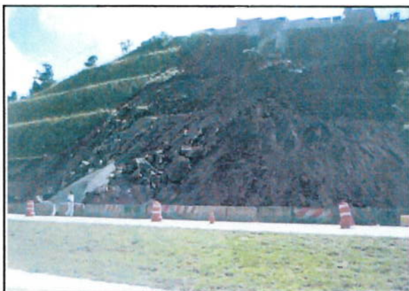
FOTO 1.1 Rodoanel Mário Covas. Verifica-se escorregamento de grande dimensão, moradias em situação de riscos e um volume considerável de materiais mobilizados.
