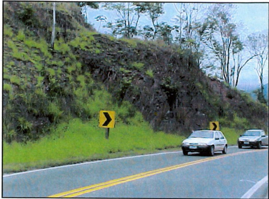
FOTO 8.8 Escorregamento no contato solo/rocha, e de lascas de rocha, km 367+100 ao 367+200 LE.
