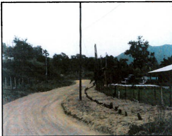
FOTO 8.29 Estrada Velha Pedro de Toledo - Miracatú. Verifica-se traçado geométrico com rampas pouco acentuadas e estrada cascalhada.
