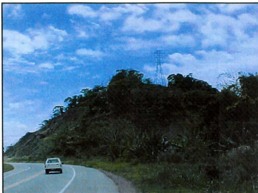
FOTO 8.25 Linha de alta tensão que poderá ser danificada com a evolução dos processos. Verifica-se grande ruptura na parte central da foto, km 353+500 LE.
