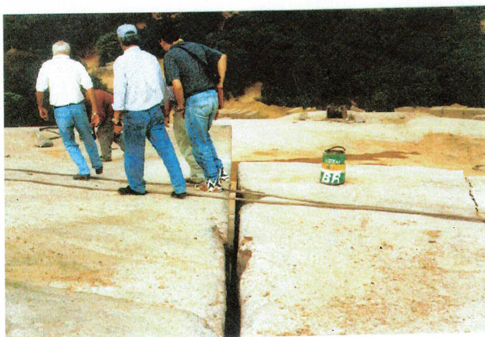
Figura 15 — Ranhura na rocha obtida com a utilização do equipamento de jato de chama.
