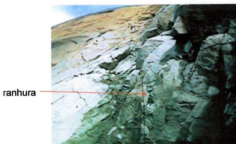
Figura 20 — Corte vertical com fio diamantado.
