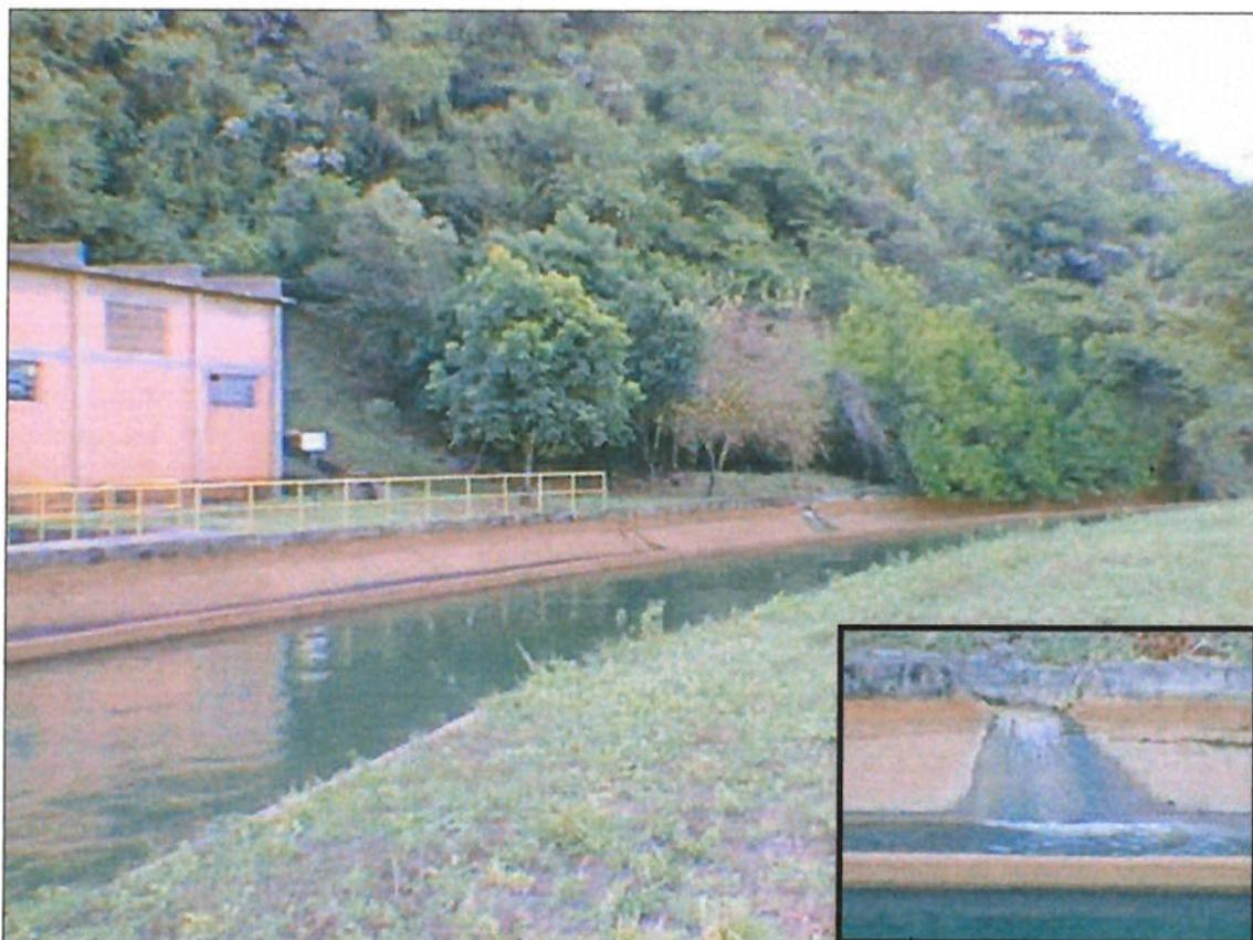
**Foto 6.3** – Trecho do rio onde se observa o revestimento das margens. No canto direito inferior, observa-se o detalhe do revestimento das margens e o divisor de canais. (Data: maio/99)
