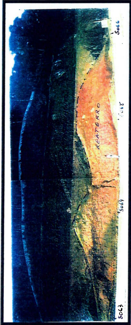
Foto 6.15 - Segmento onde ocorreu um escorregamento no talude inferior e a proteção com reaterro provisório
