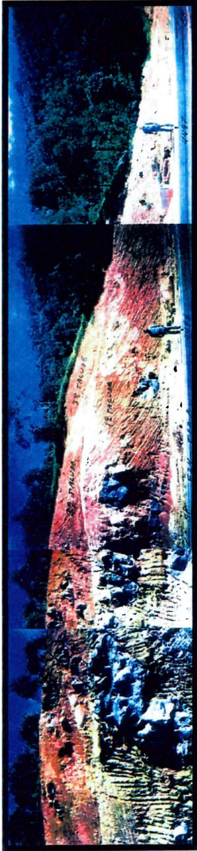
Foto 6.3 - Presença de muitos blocos rochosos no talude inferior e erosão acima, no contato solo-rocha
