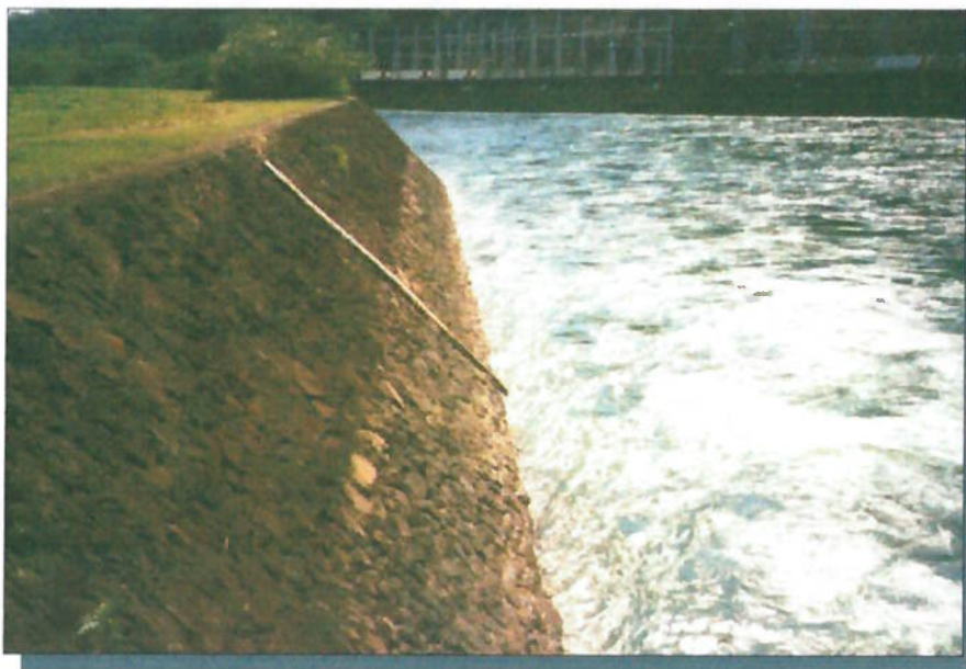
Foto 24 – Canal de restituição da UHE Chavantes revestido com pedra amarrada.
