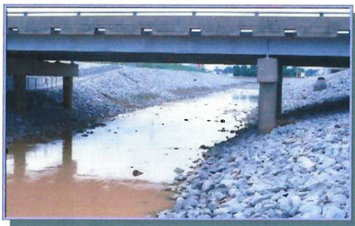
Foto 21 – Enrocamento de proteção ( rip-rap ).
