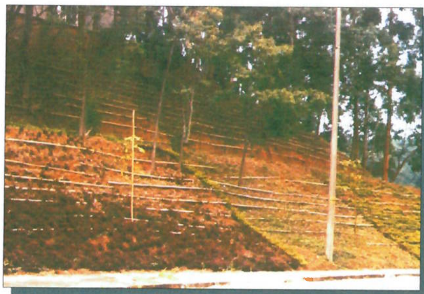
Foto 30 – Talude do Instituto de Química da USP revegetado com leiras.
