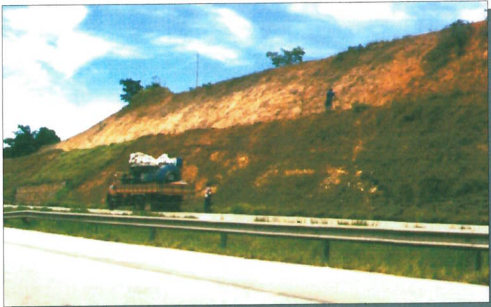
Foto 31 – Aplicação de hidrossemeadura em talude rodoviário.
