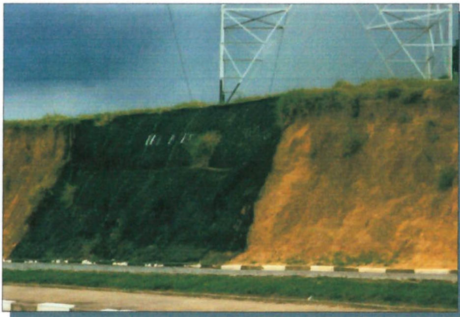
Foto 15 – Imprimação asfáltica garantindo a proteção do talude do maciço de fundação de torre de transmissão.
