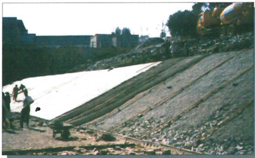
Foto 23 – Recobrimento de colchão Reno ® com argamassa sobre transição de brita.
