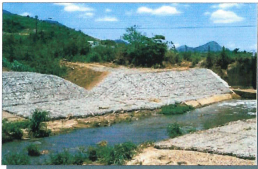
Foto 22 – Talude protegido com colchão Reno®.
