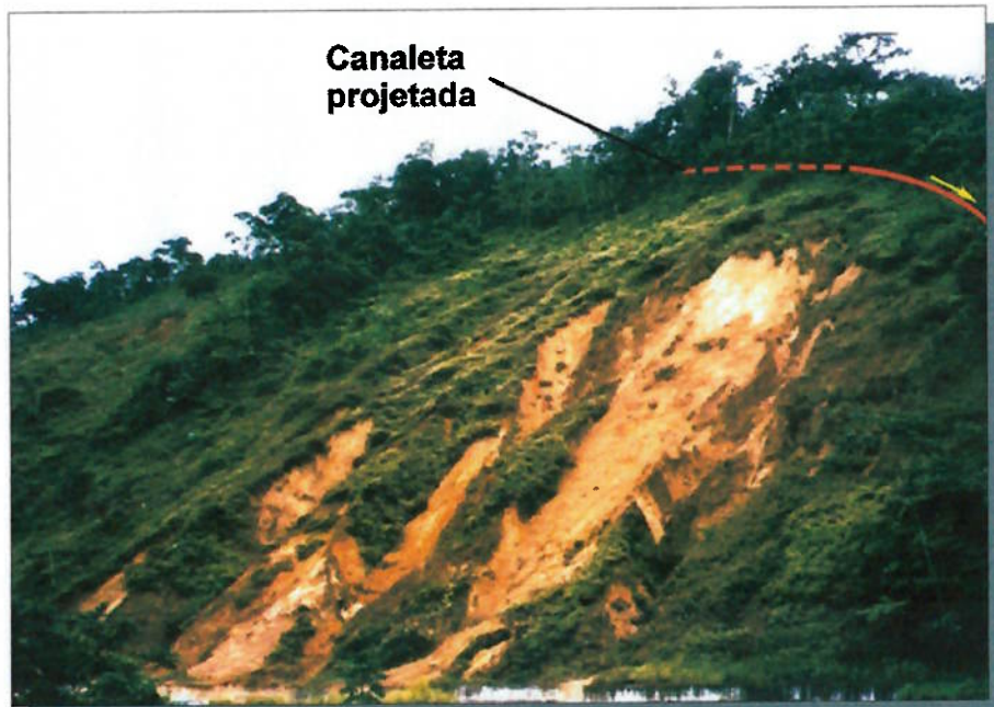
Foto 11 – Erosão em talude com indicação do traçado de canaleta de drenagem (1996).
