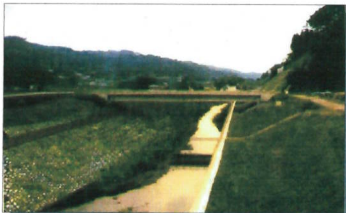
Foto 18 – Crescimento de vegetação em meio ao revestimento granular.
