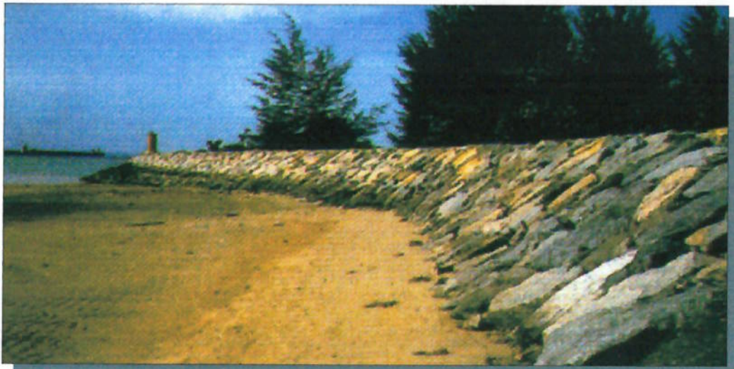
Foto 17 – Talude protegido com enrocamento rochoso.
