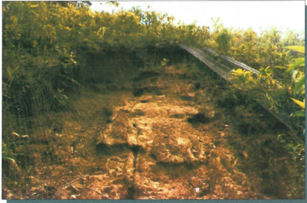
Foto 34 – Escorregamento e erosão em talude inicialmente protegido com grama-armada.
