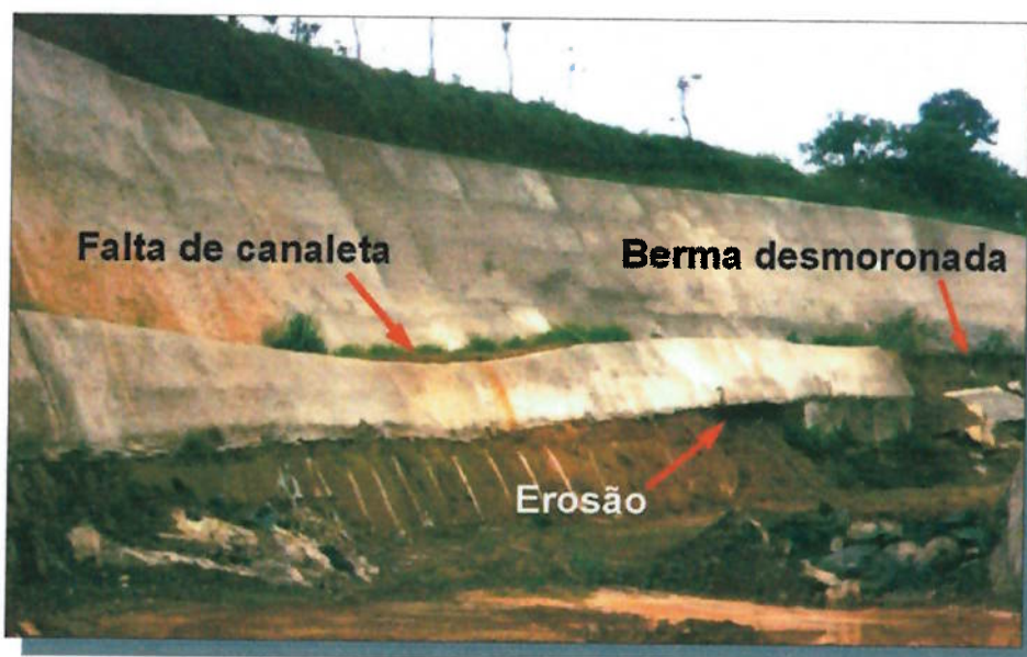
Foto 13 – Talude revestido com concreto projetado e sem dispositivos de drenagem adequados.
