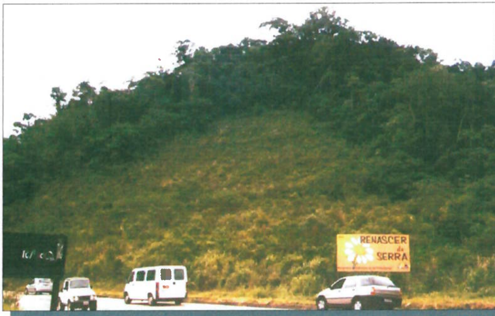
Foto 27 – Talude em Mata Atlântica revestido somente com grama em 1997 (foto de novembro de 2002).
