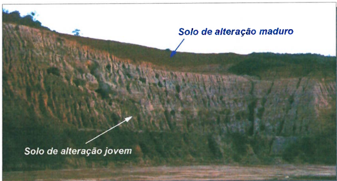
Foto 29 – Corte em solo de alteração intensamente ravinado. Notar a porção superior preservada.
