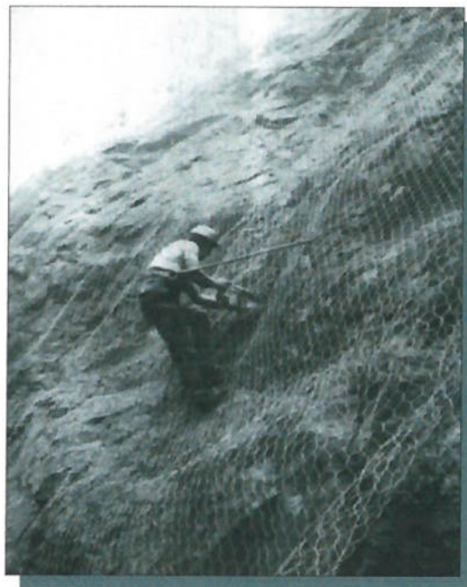
Foto 37 – Aplicação de tela metálica.
