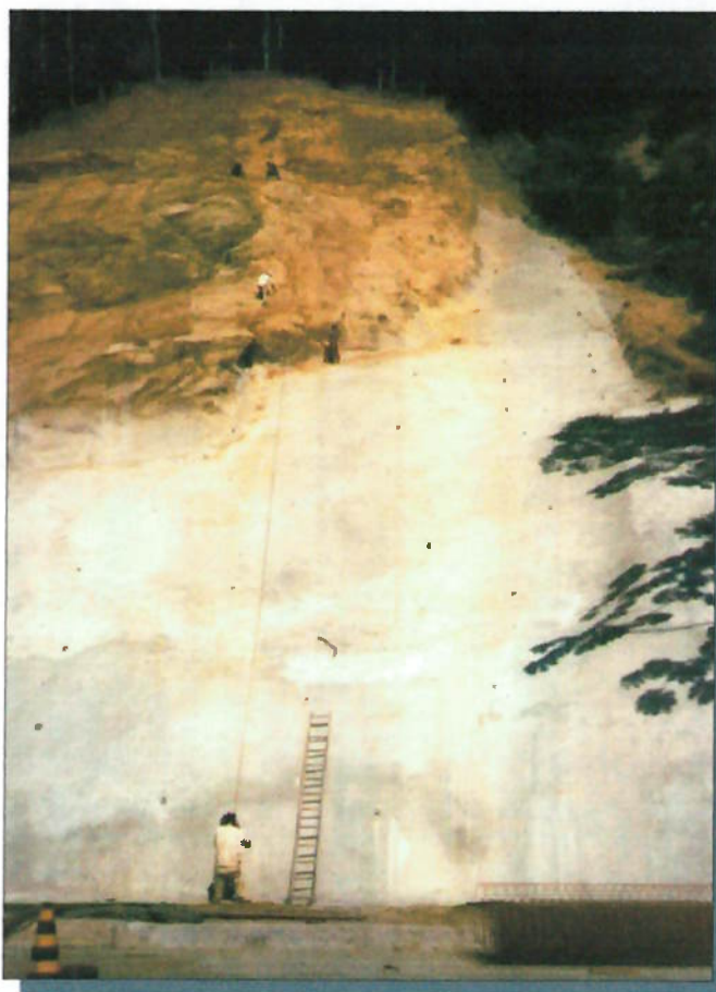
Foto 16 – Aplicação de concreto projetado com tela.
