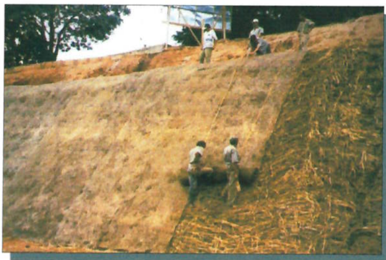
Foto 35 – Exemplo de aplicação de biomanta.
