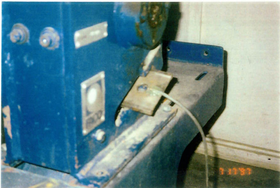
Figura 3.4. Colocação de abandeira no britador
