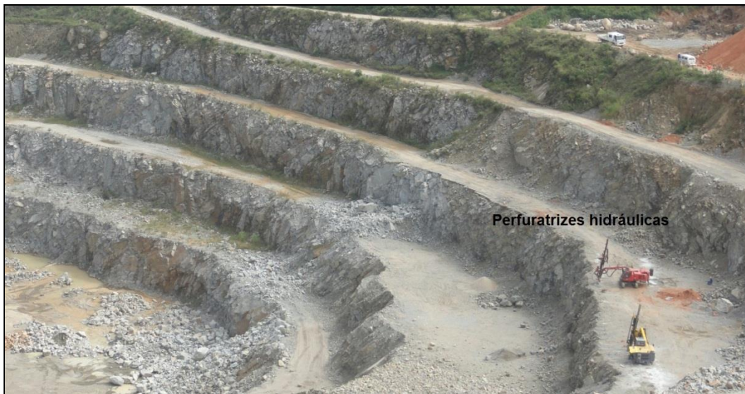
Figura 22- Perfuratrizes hidráulicas na pedreira Juruauçu
