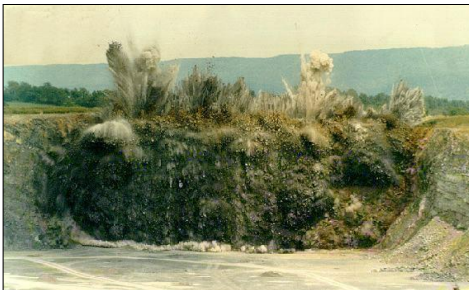
Figura 14- Detonação de uma bancada com ultralanchamento Fonte: FAJERSZTAJN, 2010
