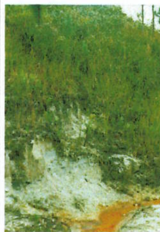
33-1: Talude remanescente de lavra, com duas grande feições de escorregamentos planares, em rocha alterada (pegmatito). Ocorrem feições erosivas sobre a massa movimentada.
