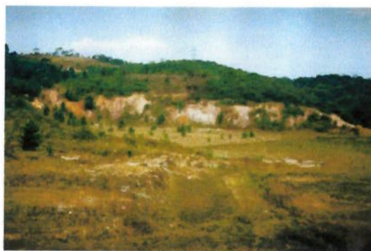
Vista para os taludes remanescentes de lavra, com feições erosivas em toda a extensão.
