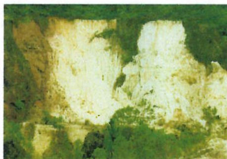
33-1: Talude remanescente de lavra, com duas grande feições de escorregamentos planares, em rocha alterada (pegmatito). Ocorrem feições erosivas sobre a massa movimentada.
