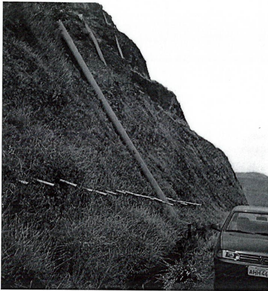
Figura 3.22. Drenos instalados em talude suscetível a percolação de águas subterrâneas
