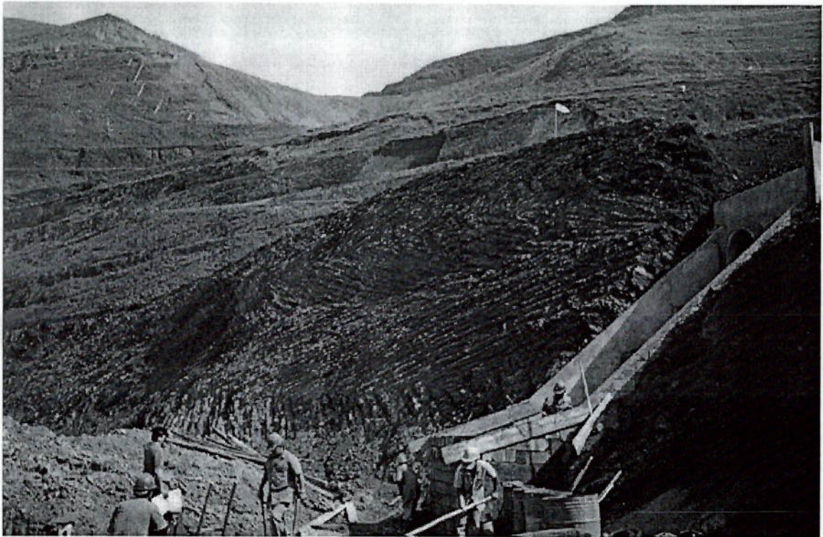
Figura 3.21. Construção de escada d'água em bancada de cava definitiva
