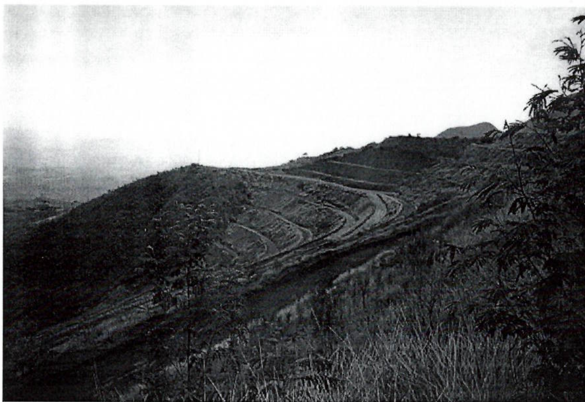
Figura 5.26. Aspecto de pilha de estéril após cerca de 5 anos de encerramento
