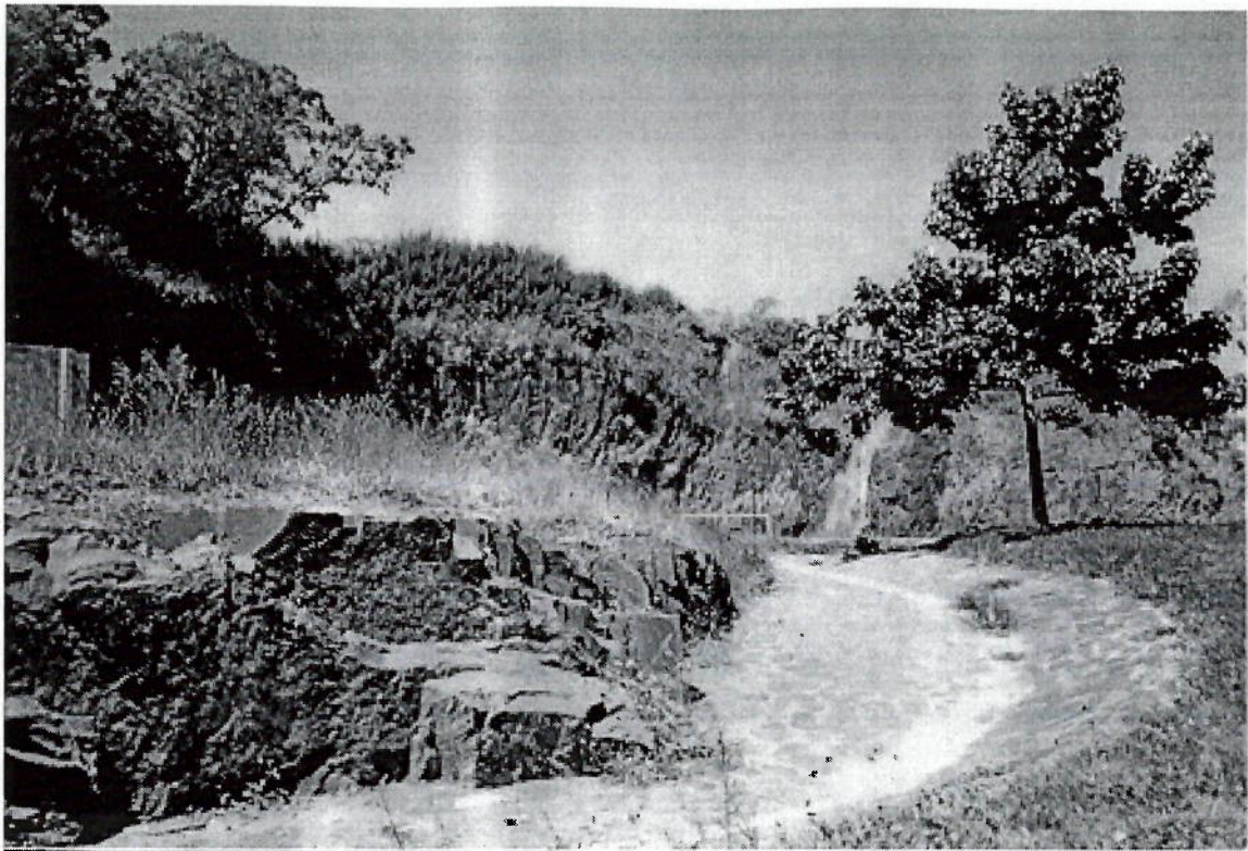
Figura 5.32. Canaleta de drenagem entre setores da cava
