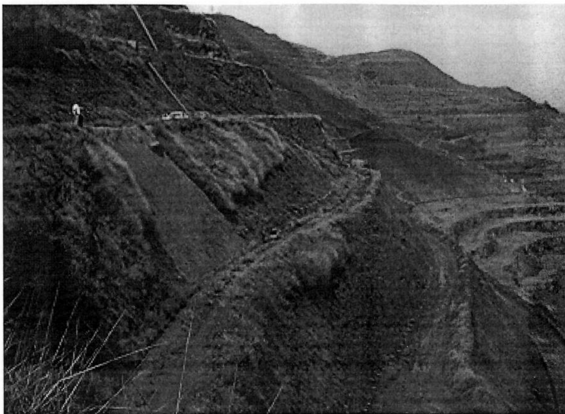
Figura 5.19. Execução de reparos localizados - Mina de Córrego do Feijão
