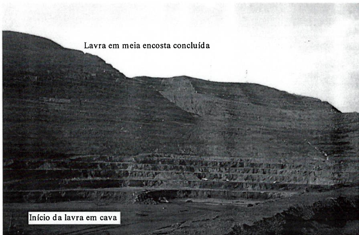
Figura 5.11. Aspecto atual dos taludes da cava (os inferiores correspondem a bancadas em lavra) - Mina de Córrego do Feijão
