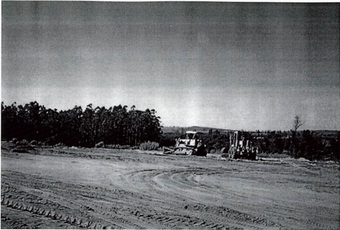
Figura 5.7. Execução de aterro e conformação topográfica da área da barragem desativada
