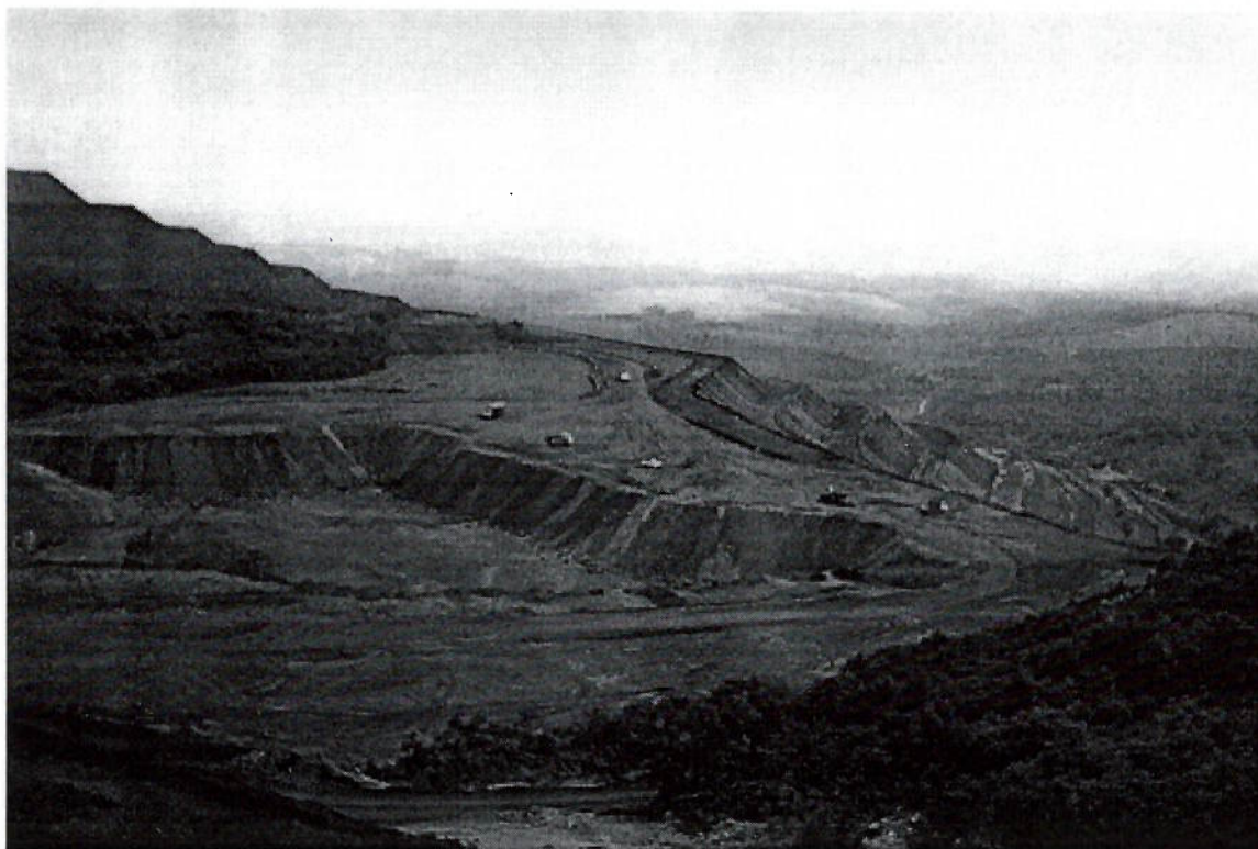
Figura 5.23. Construção das pilhas de estéril de forma ascendente - Mina de Córrego do Feijão
