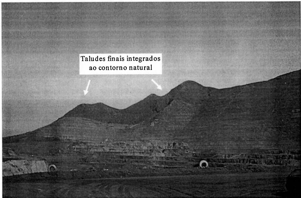
Figura 5.20. Aspecto dos taludes definitivos, à distância - Mina de Córrego do Feijão
