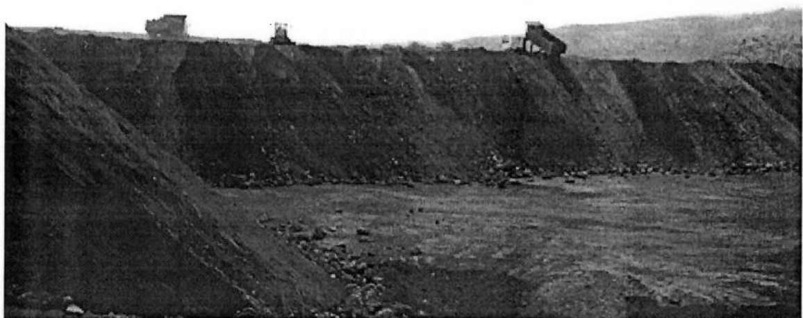
Figura 5.22. Basculamento de caminhões formando a pilha de estéril - Mina de Córrego do Feijão
