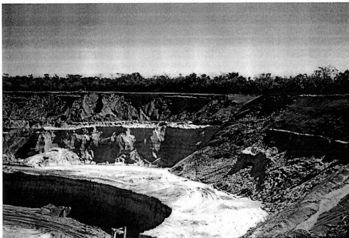
Figura 5.4. Aspecto dos taludes, evidenciando a baixa resistência das camadas
