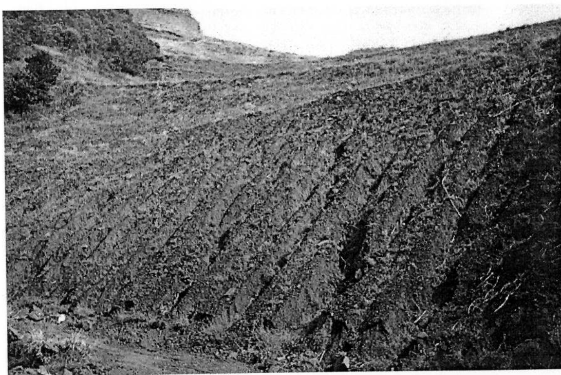
Figura 3.24. Feições típicas de pilhas de estéril erodidas
