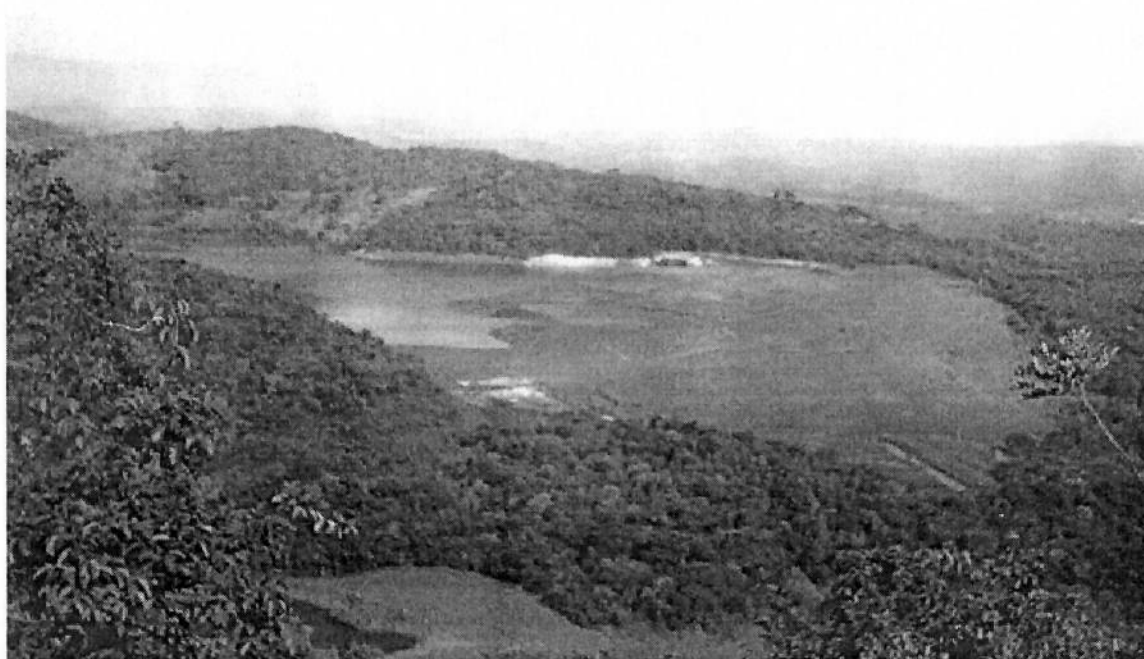
Figura 2.6. Barragem de rejeito- Ferteco
