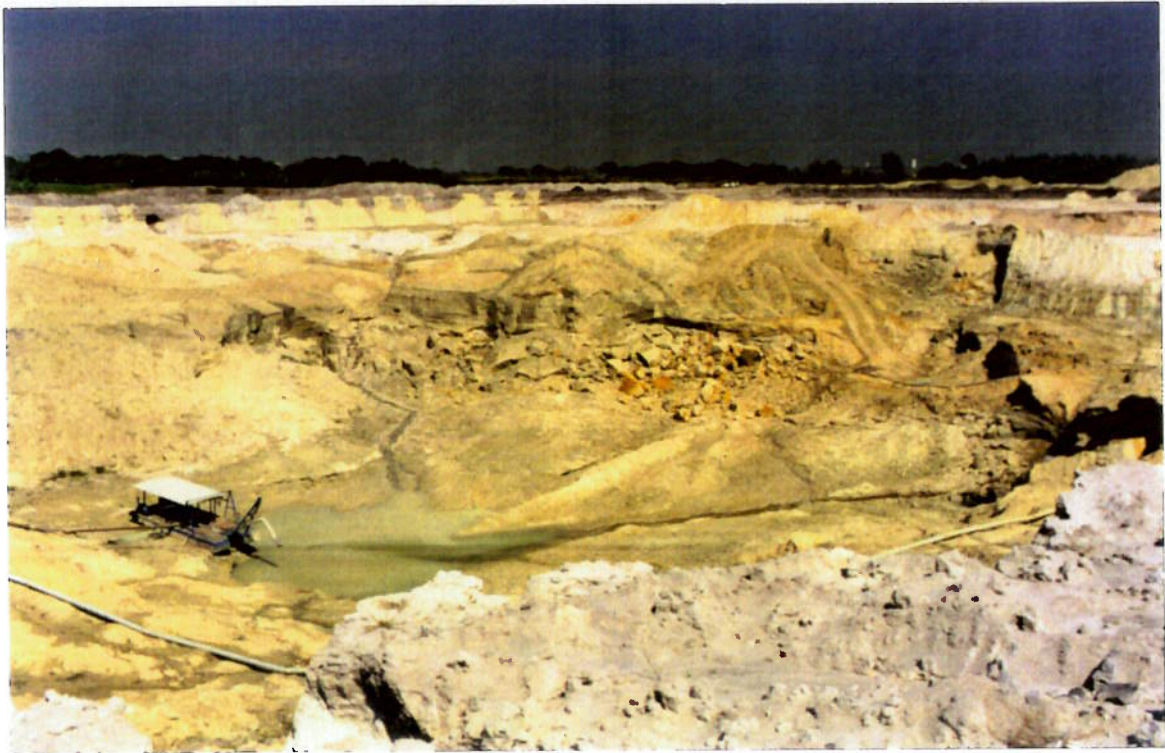
Foto 5: Equipamento de bombeamento de polpa em cava seca (Porto Oásis).
