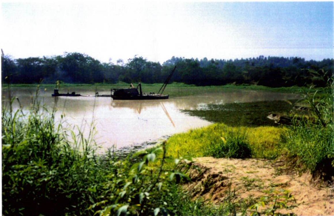
Foto 2: Dragagem em cava submersa com carregamento de barcaça. Porto Navegantes.
