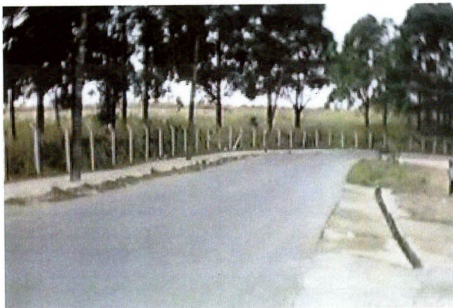
FOTO 13 - Cercamento das divisas do terreno.
