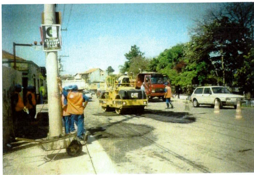
FOTO 08 - Recuperação do pavimento asfáltico nas vias de acesso ao aterro (setembro de 2000).
