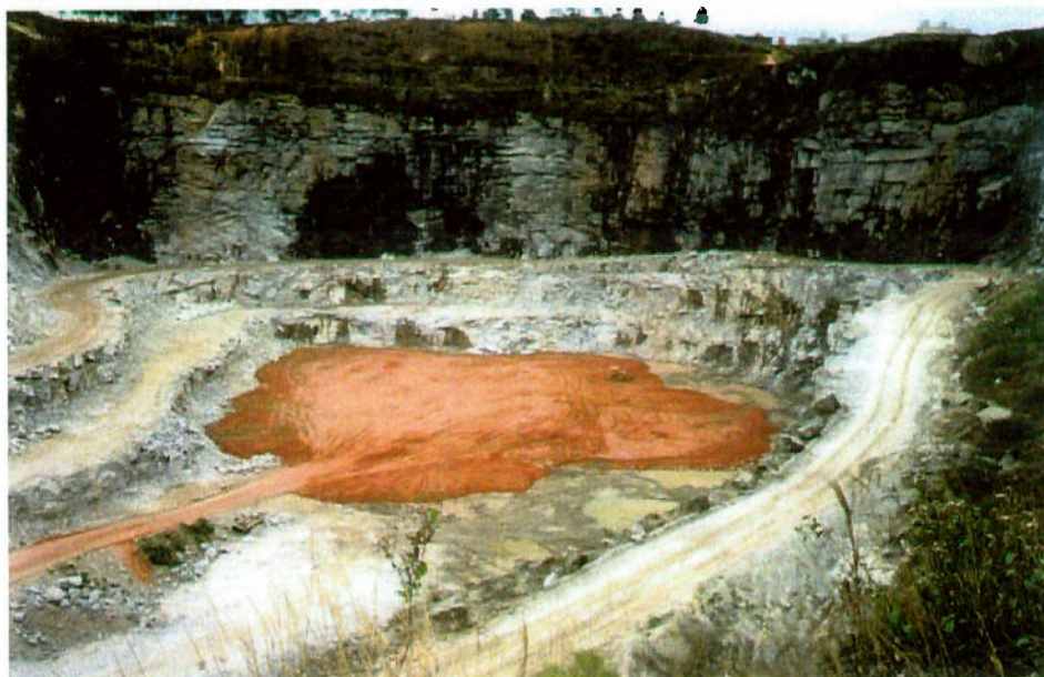
FOTO 03 - Regularização e sistema de impermeabilização de base do aterro: execução (agosto de 1999)
