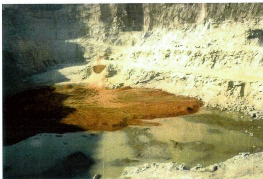
FOTO 04 - Regularização e sistema de impermeabilização de base do aterro: execução (agosto de 1999)
