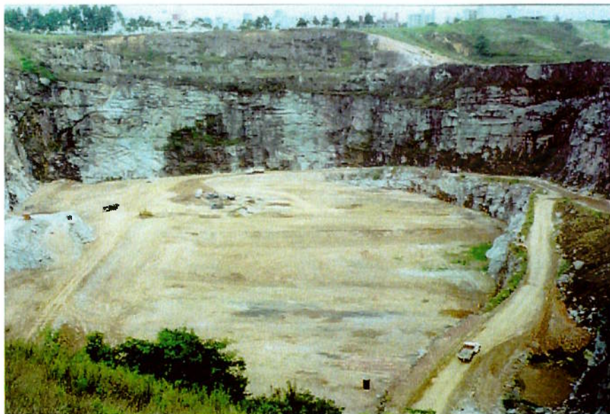
FOTO 11 - Vista geral do aterro: alteamento realizado de forma progressiva e distribuída.
