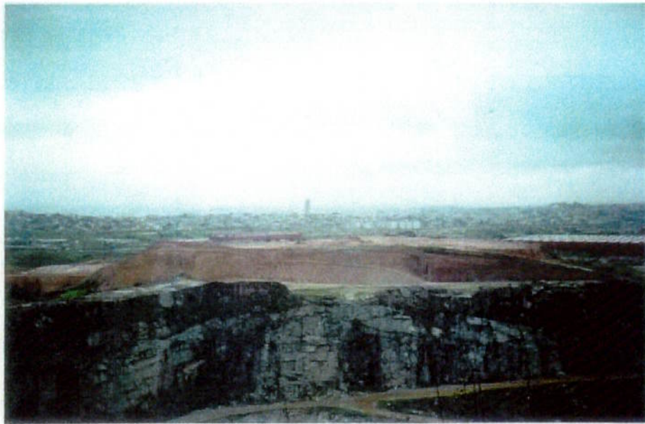
FOTO 17 - Bota-fora - vista geral.
