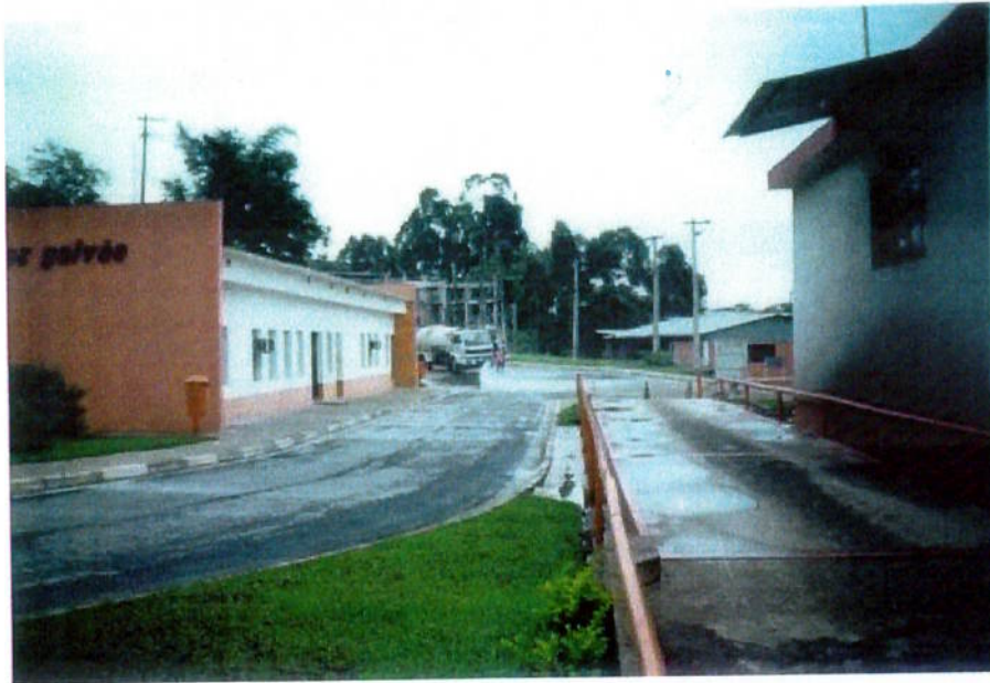
FOTO 05 - Acessos internos - umectação sistemática.
