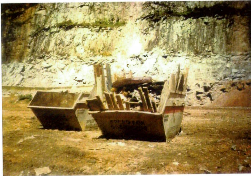
FOTO 10 - Caçamba estacionária com "rejeitos" - material não inerte segregado no lançamento e espalhamento.
