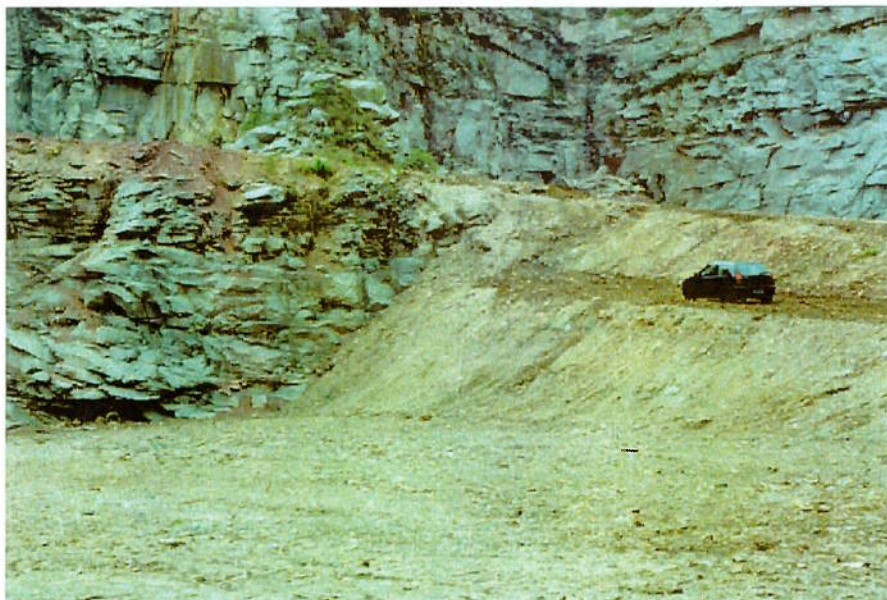
FOTO 12 - Talude mais elevado do alteamento progressivo do aterro, junto ao acesso à praça de descarga. Não são observadas feições erosivas ou de instabilização.
