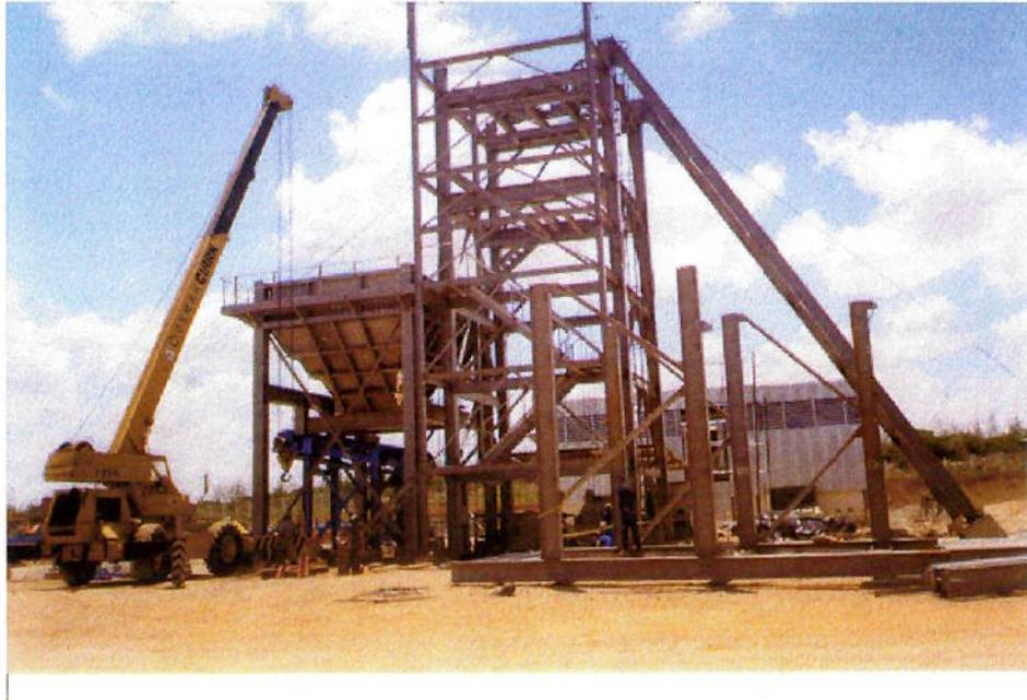
Foto 5.- Instalação do primeiro módulo da torre de içamento.
