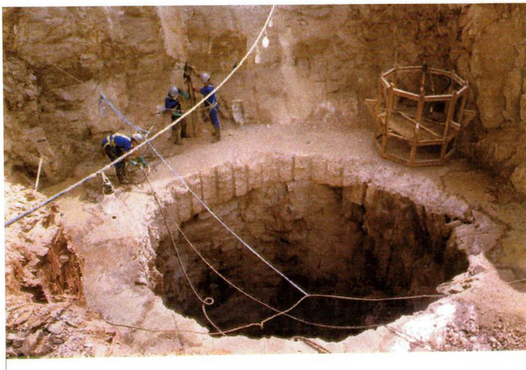
Foto 3 – Alargamento do diâmetro na embocadura do poço
