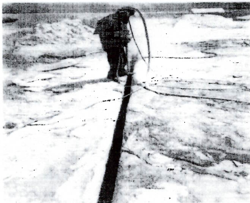
Foto 11 - "Flame jet" fazendo abertura de canais em maciços rochosos
