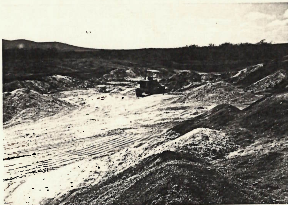
Foto 2.6 - Vista de uma operação de decapeamento com pá carregadeira.
