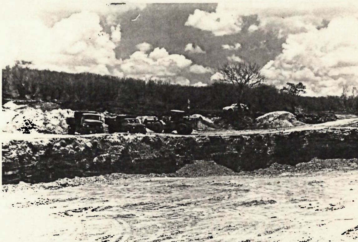
Foto 4.2 - Foto mostrando a remoção (por pá carregadeira) de camada estéril sobreposta ao pacote argiloso, objetivando o avanço da bancada inferior.
