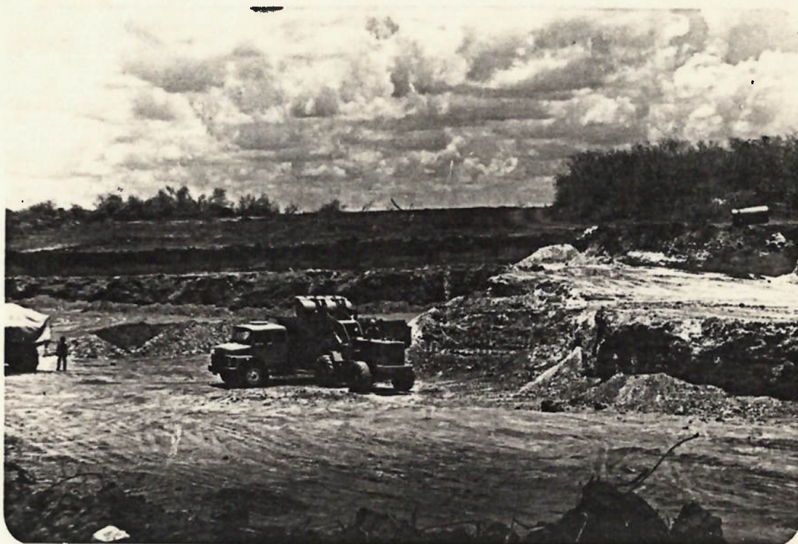
Foto 5.2 - Foto mostrando o desmonte e carregamento por pá carregadeira e transporte por caminhões basculantes da argila bentonítica.
