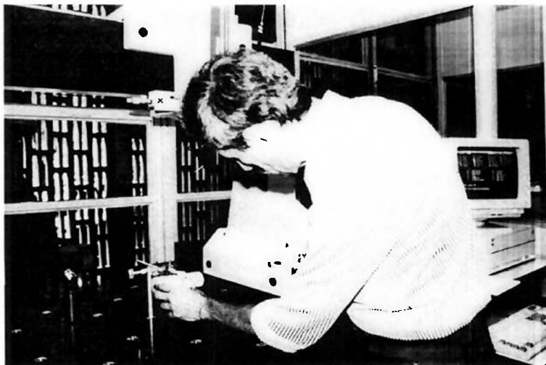
Figura 5.7 - Verificação dimensional em máquina de medição tridimensional
