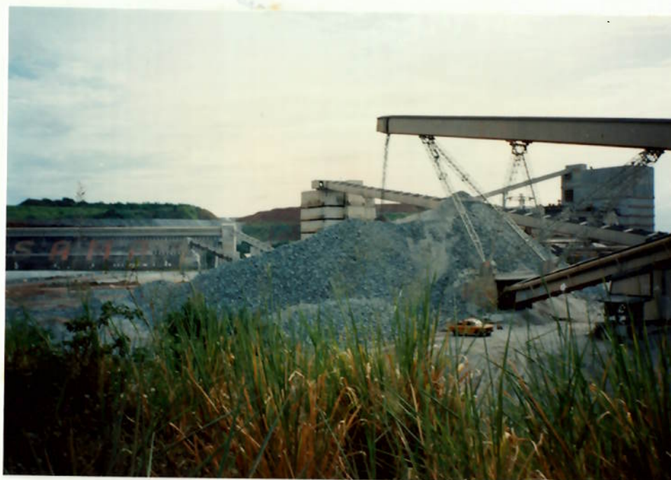
Foto 9 - Vista geral do pátio de estocagem do minério britado e no fundo o silo de minério seco - SMS. Foto gentilmente cedida por OLIVEIRA, M.C.B.
