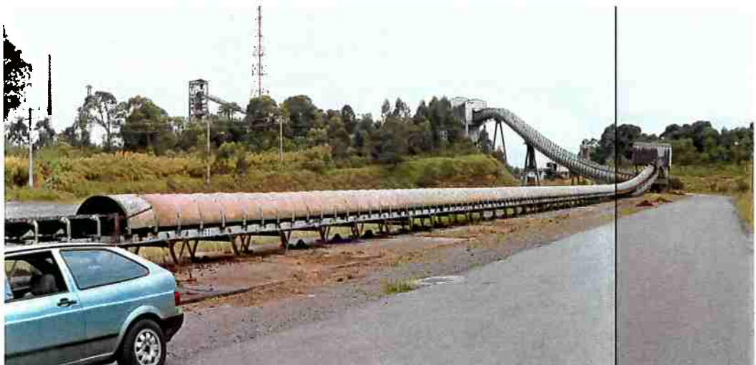
FIGURA 47 - VISTA DO TRECHO ENCAPSULADO DO CIRCUITO DE BRITAGEM E TRANSPORTE POR CORREIAS, ATÉ PRÓXIMO AO CARREGAMENTO DA RETORTA
