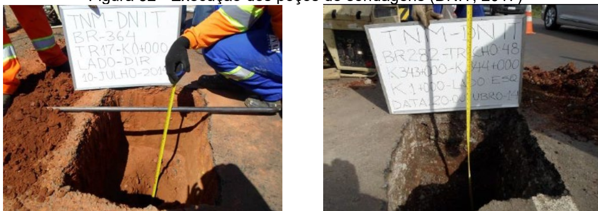
Figura 32 - Execução dos poços de sondagens (DNIT, 2017)
