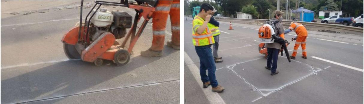
Figura 3.5 – Execução de cortes no pavimento para a instalação dos sensores
