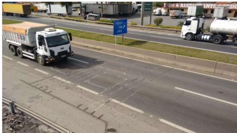
Figura 3.1 – Veículo trafegando sobre o sistema HS-WIM na BR-381
