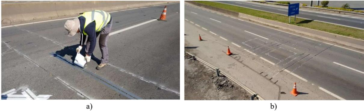
Figura 3.7 – a) Preenchimento dos cortes; b) Aspecto final do pavimento.
