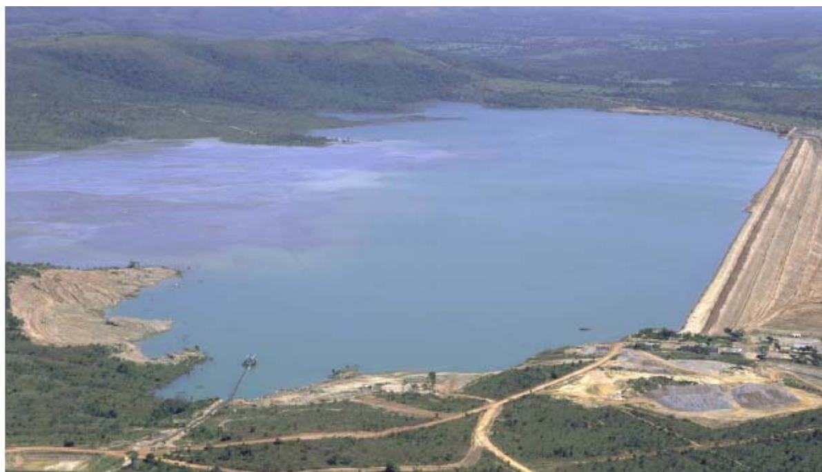
Figura 15. Represamento em bacia: mineração de ouro, Rio Paracatu Mineração, Minas Gerais (ICME-UNEP 1998).
