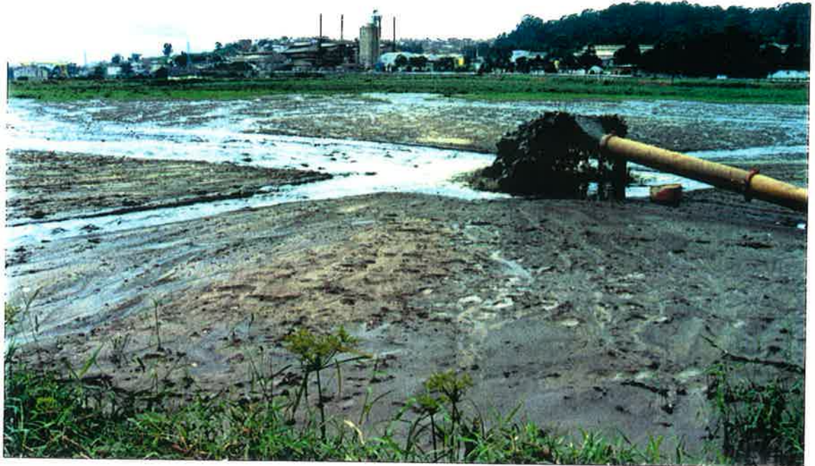
Figura 4.7 - Vista do material na caixa do bota-fora 7
