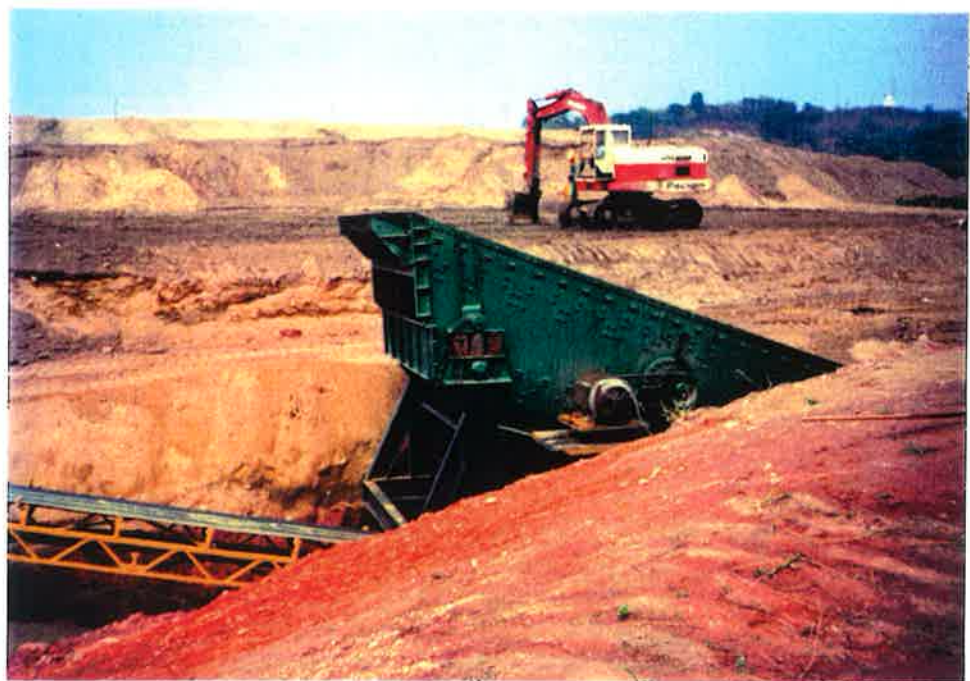
Figura 4.5 - Área de disposição final do Lote 1
