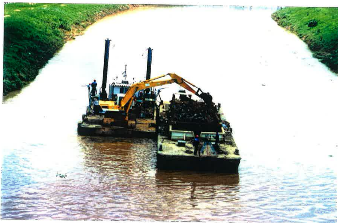
Figura 4.2 - Lançamento do material escavado em uma barcaça móvel
