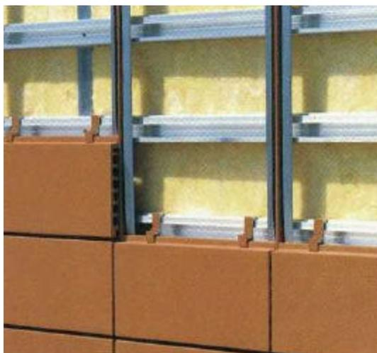
**Figura 2-15-Fachada-cortina com a utilização de revestimento em litocerâmica (SHILDAN USA INC , 2002)**
