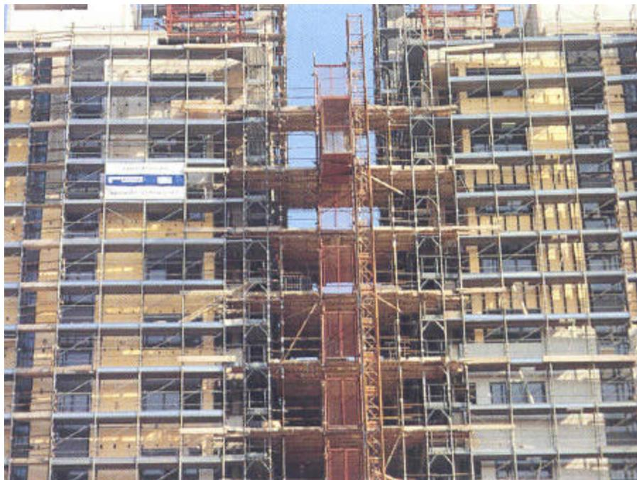
**Figura 4-3-Montagem de fachada-cortina com placas de grês porcelanato com a utilização de andaime fachadeiro (MARAZZI, 1997)**
