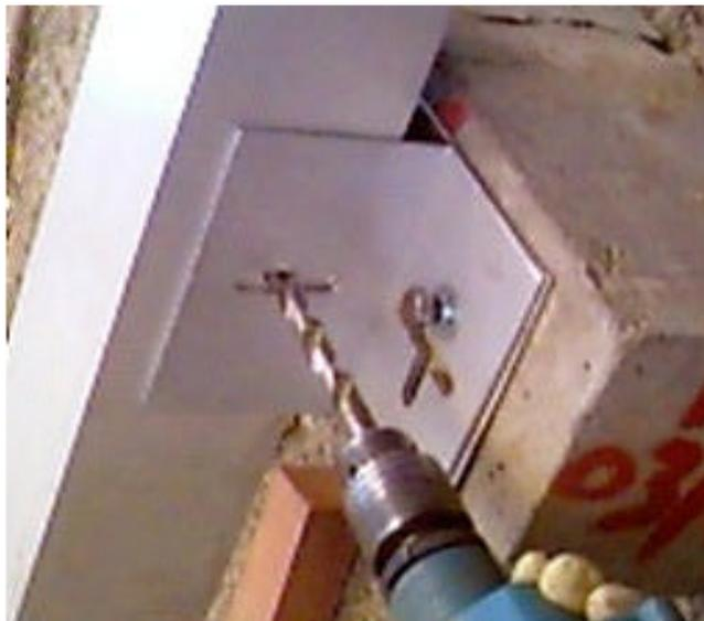
*Figura 4-8-Fixação do montante à ancoragem (CEUSA; LEME, 2002)*
