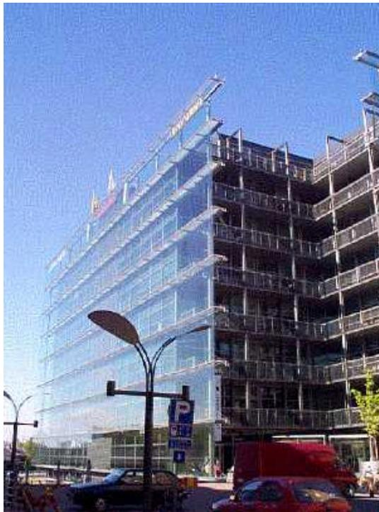
**Figura 2-13-Edifício Sanomatalo com fachada com dupla-pele-de-vidro - Helsinque (UUTTU, 2001)**
