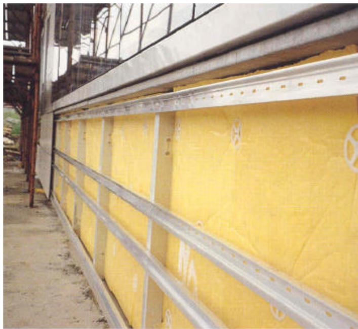
*Figura 3-6- Isolamento térmico (manta de fibra de vidro) em fachada ventilada (MARAZZI, 1997)*
