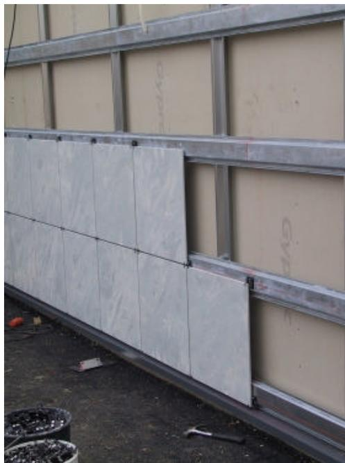
**Figura 2-19-Fachada-cortina com placas de grês porcelanato empregada como sistema integrado com placas de gesso acartonado (MÄNTYLÄ, 2002)<sup>6</sup>**
