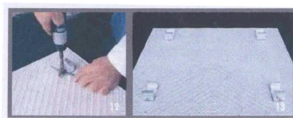
*Figura 4-14-Instalação de ganchos no tardo da placa (GRANITI FIANDRE, s.d.)*
