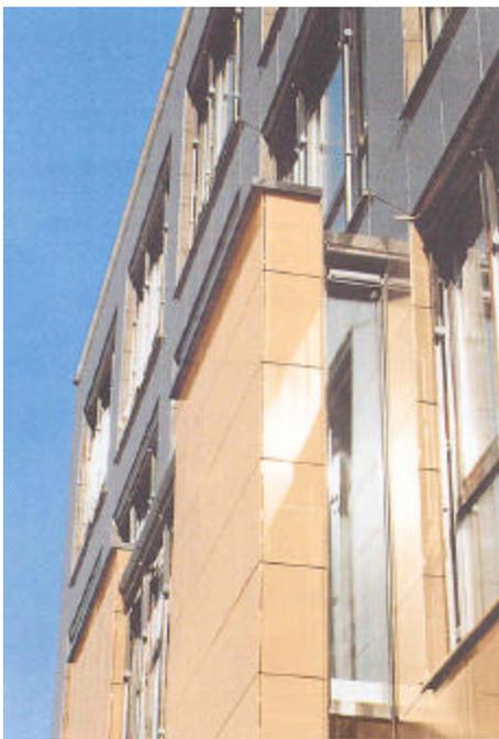
**Figura 3-28-Fechamento do entorno da abertura com placas de grês porcelanato (MARAZZI, 1997)**
