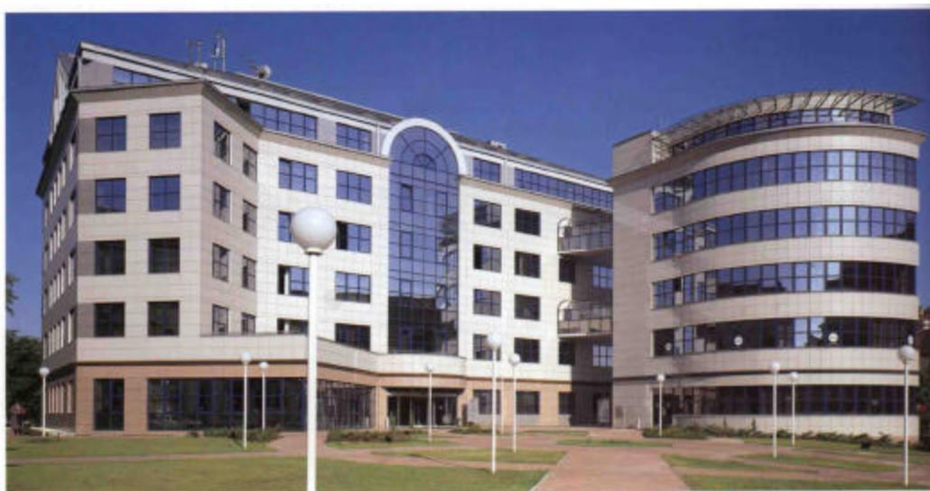
**Figura 2-18-Fachada-cortina com placas de grês porcelanato em edifício de múltiplos pavimentos (MARAZZI, 1997)**
