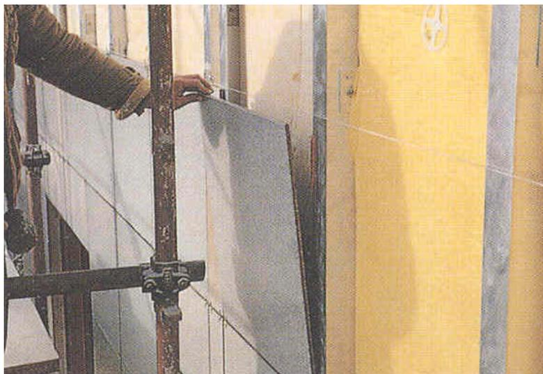
**Figura 4-15-Instalação de placa em revestimento com acoplamento visível (MARAZZI, 1997)**
