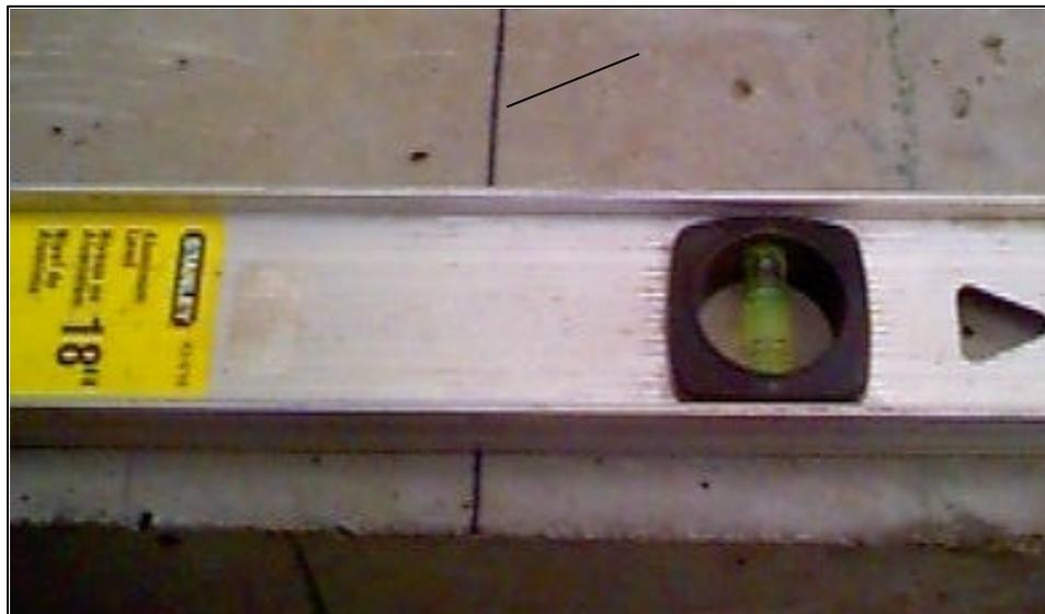
*Figura 4-6- Marcação do posicionamento das ancoragens (CEUSA; LEME, 2002)*
