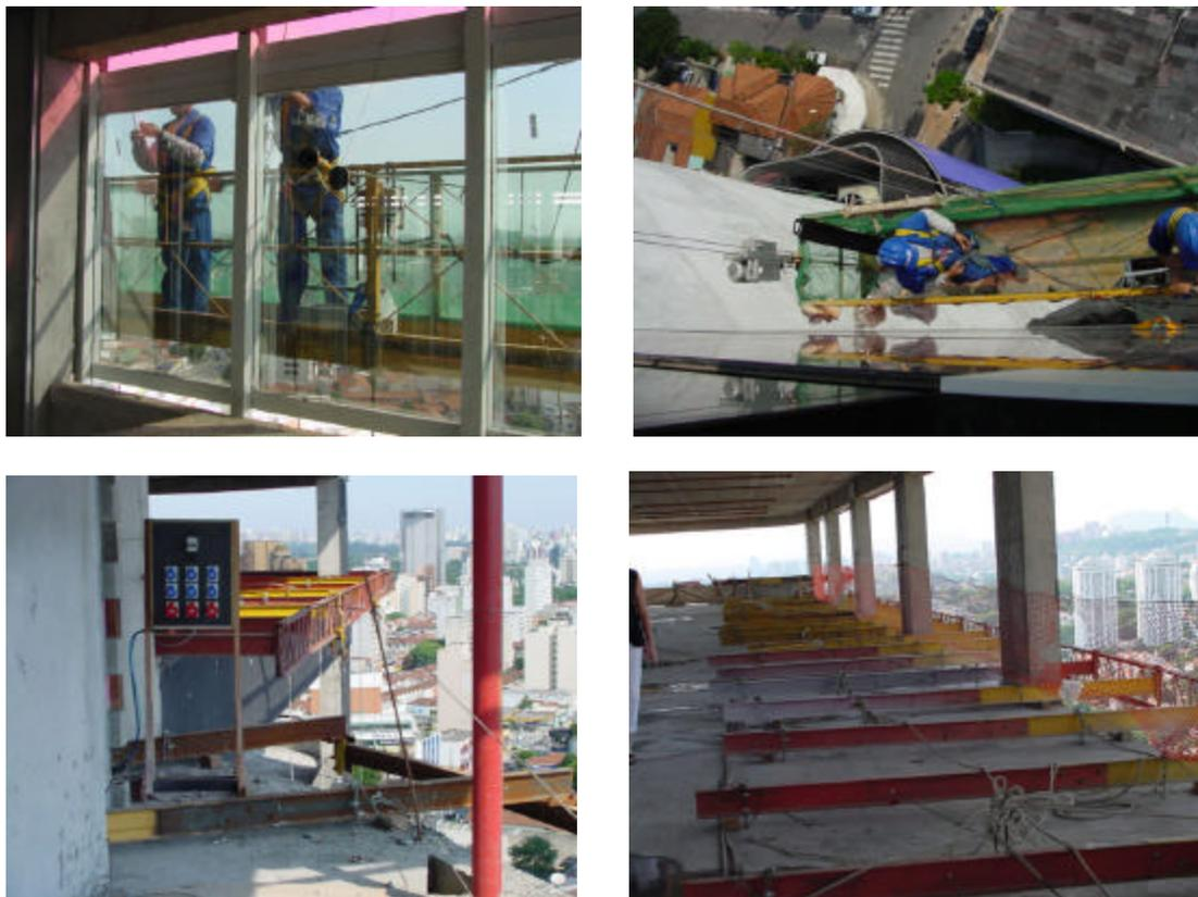
*Figura 4-4-Balancim elétrico leve com movimento de translação horizontal*
