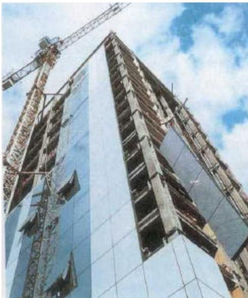
*Figura 2-6-Fachada cortina pré-fabricada (TECTÓNICA, 1997)*
