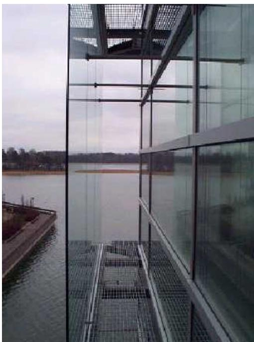
**Figura 2-14-Cortina externa com vidro simples e fachada principal com vidro duplo separadas pela câmara de ar (cavity), (UUTTU, 2001)**
