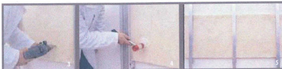
*Figura 4-9- Instalação do isolante térmico (GRANITI FIANDRE, s.d.)*
