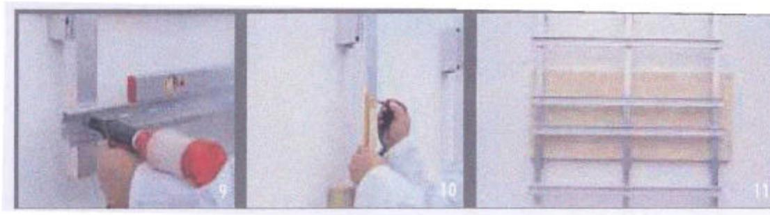
**Figura 4-11- Posicionamento e fixação das guias sobre os montantes (GRANITI FIANDRE, s.d.)**
