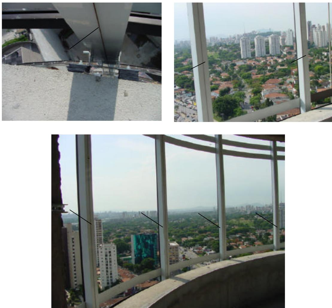
**Figura 4-5 – Arames de prumo usados como referência para o posicionamento dos montantes**
