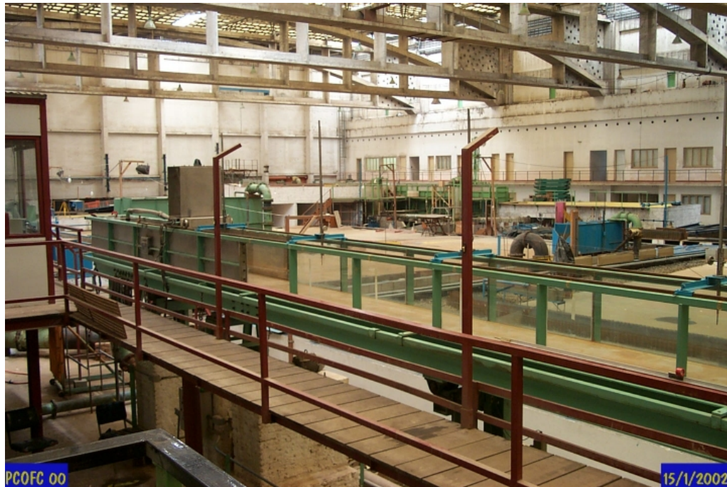
Foto 1: Vista geral do canal experimental situado no hall de ensaios do Laboratório de Hidráulica da EPUSP – CTH
