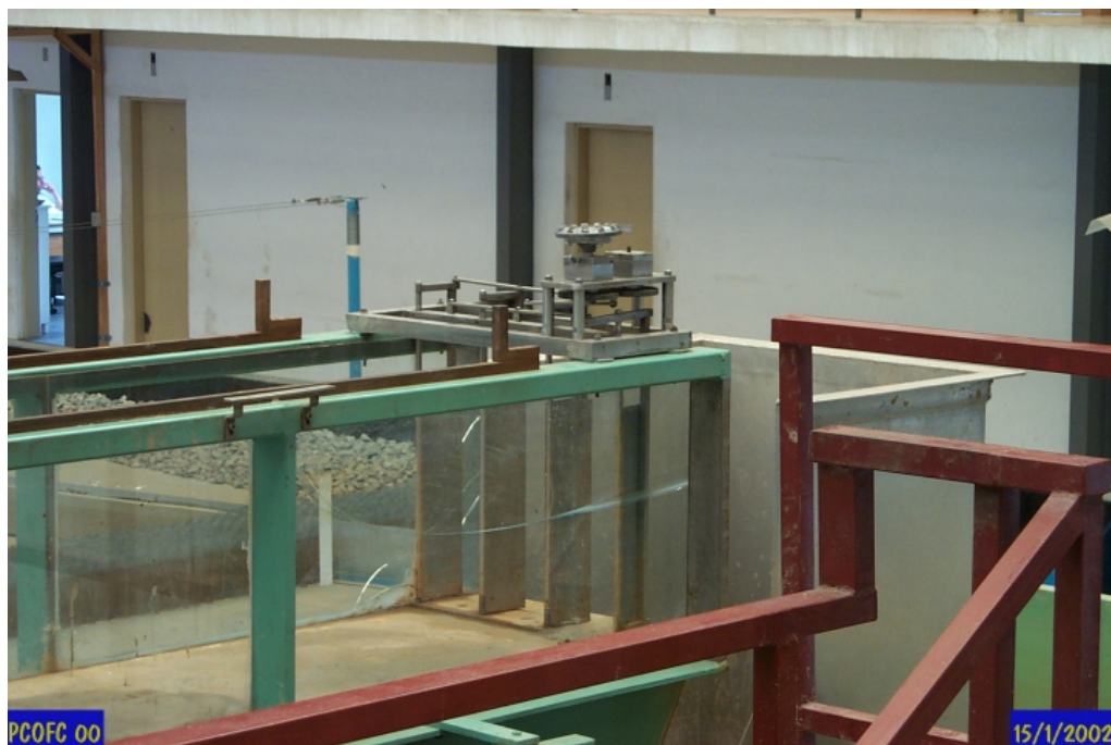
Foto 6: Comporta basculante vertical para controle do nível a jusante.
