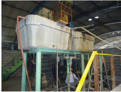
Figura 31 - Caixa elevadas para alimentação das unidades piloto no CTH
