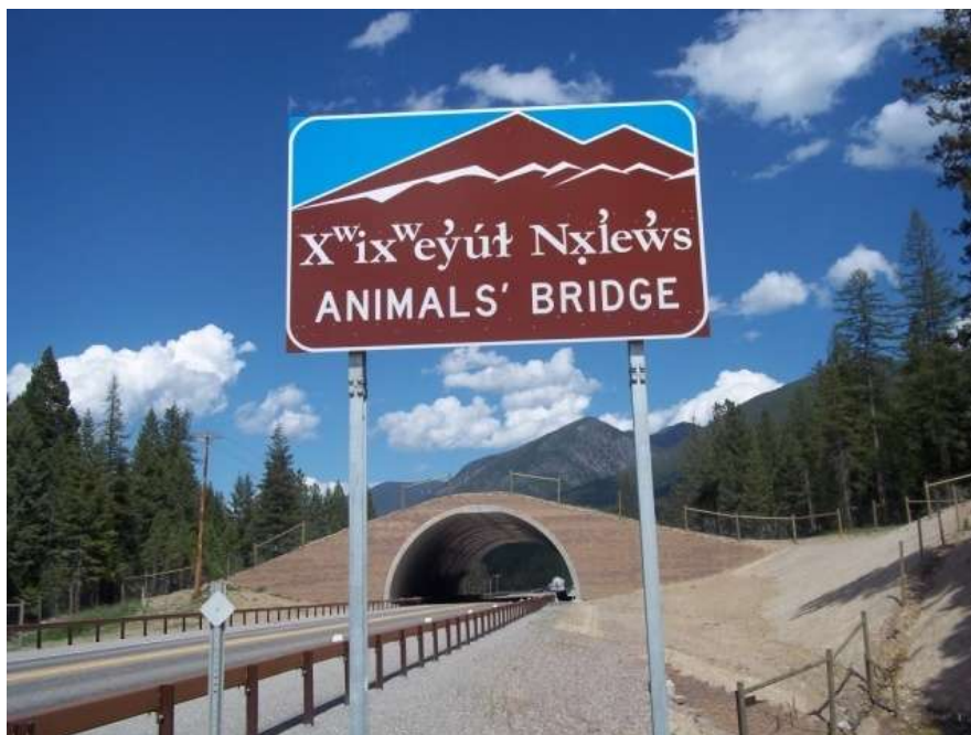
Figura 5: Viaduto de fauna na Highway 93 , em Montana, Estados Unidos. A placa de sinalização indica a passagem de fauna aos condutores na língua inglesa e indígena, uma vez que a rodovia corta uma área indígena da tribo Salish Kootenai . (Foto: Fernanda Delborgo Abra)
