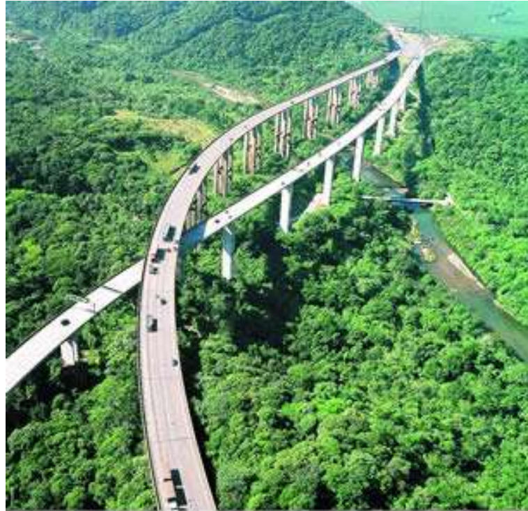
Figura 6: Elevado na SP-160, Rodovia dos Imigrantes, em São Paulo, Brasil.(ECOVIAS, 2011). (Foto: Ecovias.)
