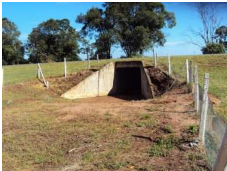
Figura 3: Passagem de fauna do tipo caixa seca, acompanhada de cerca condutora, na rodovia SP-225, em Brotas, Brasil.(Foto: Fernanda Delborgo Abra)
