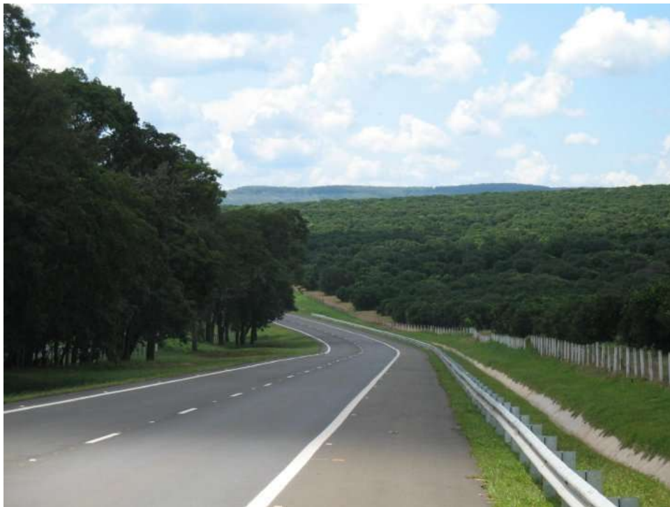
Figura 8 – Trecho da Rodovia Engenheiro Paulo Nilo Romano, SP-225, no município de Brotas (Foto: Fernanda D. Abra.).
