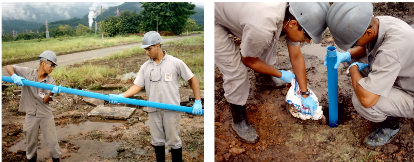
Figura 4.4 – Instalação de poço de monitoramento (P-04).
