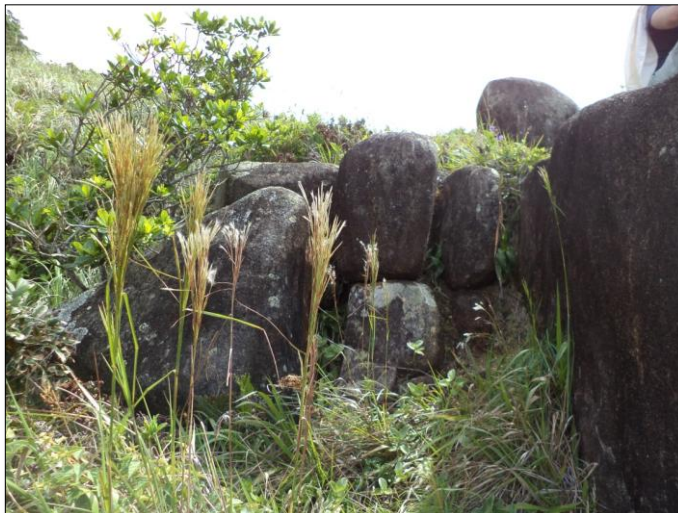
Figura 4.6.6a – A disposição dos blocos no topo do Buraco do Cação sugere que a rocha era um bloco único, que fraturou em duas direções quase ortogonais entre si, por onde os agentes de intemperismo agiram.
