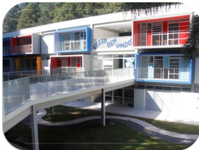
Figura 1 – Foto da fachada parcial do CEU Ricardo Ricci
