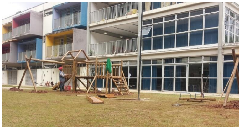
Figura 6 – Vista parcial da fachada e área externa do CEU
