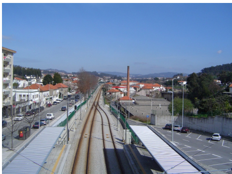
Imagem 2 – Estação de comboio de Vila das Aves
