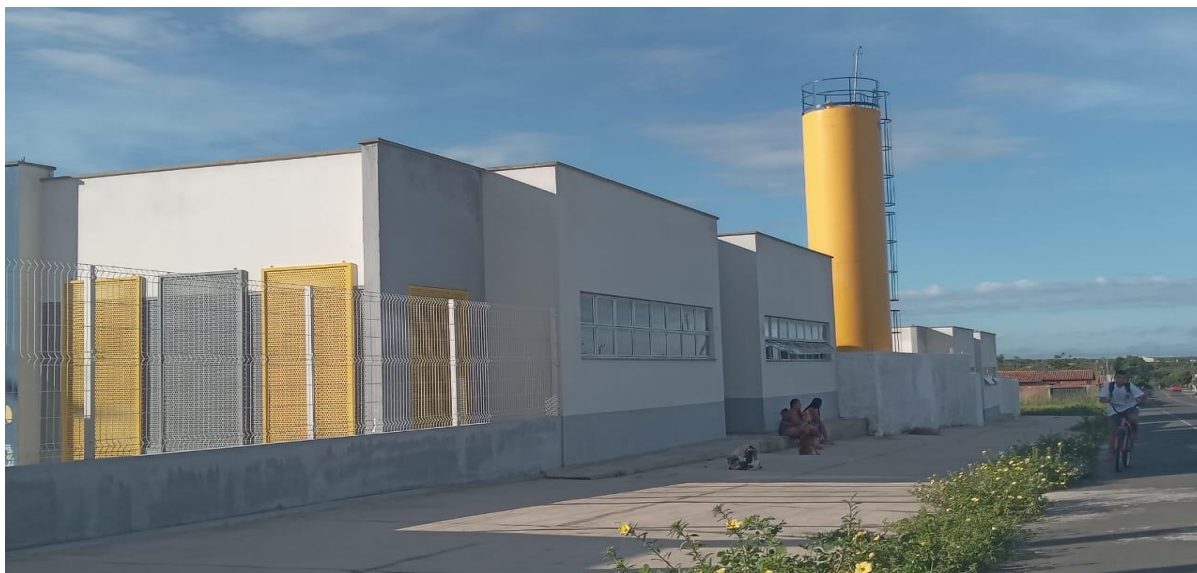
Figura 8 – Unidade 5. Creche Proinfância concluída (2023) – Parnaíba-PI
