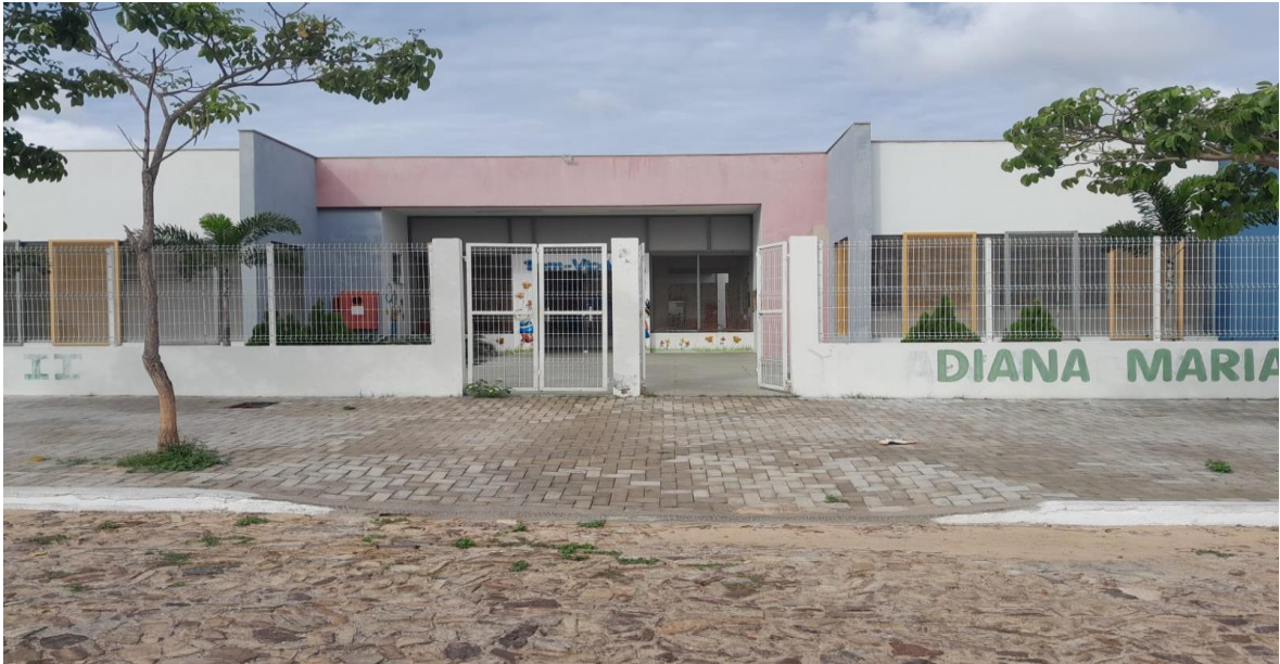
Figura 6- Unidade 3. Creche Proinfância concluída (2021) – Parnaíba-PI
