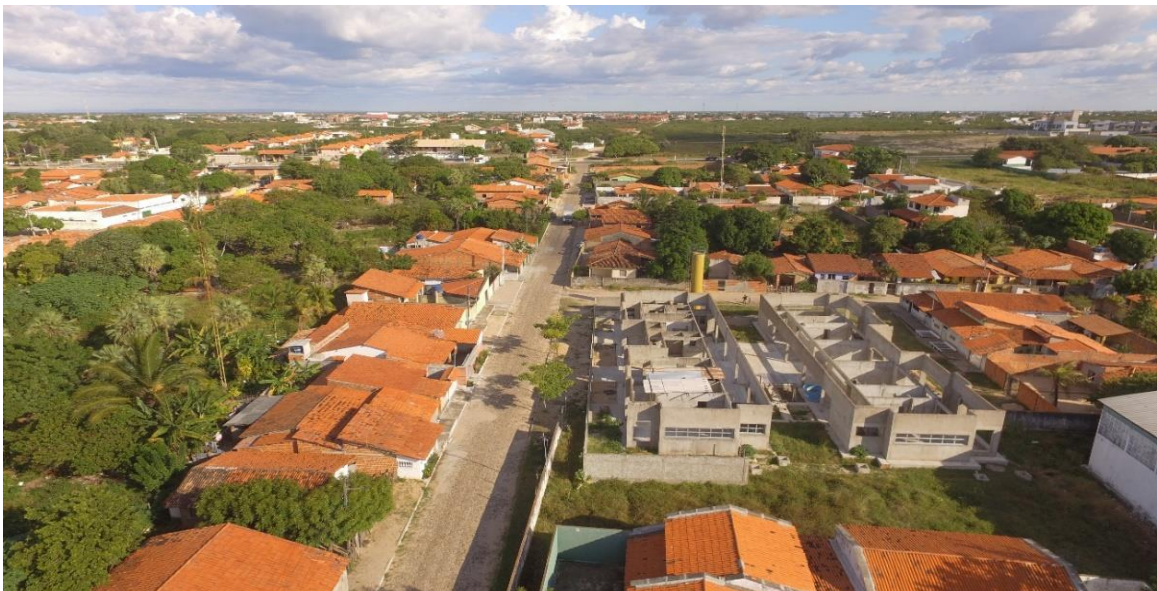
Figura 5 – Unidade 3 - Vista Panorâmica da Unidade 3. Creche Proinfância em execução – Parnaíba-PI
